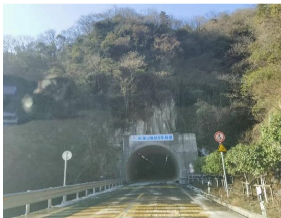
8#隧道口警示标志
