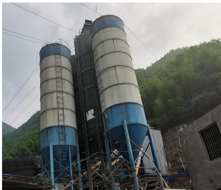
图 5.3-1 3#施工支洞混凝土拌和系统粉尘控制措施
