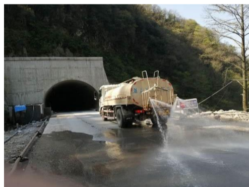
施工道路洒水
