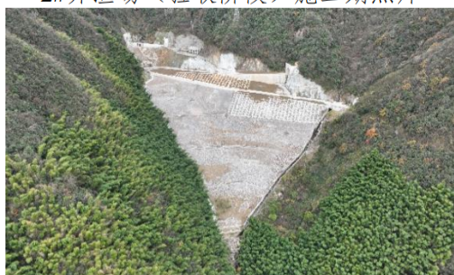
4#弃渣场（验收阶段）施工期照片
