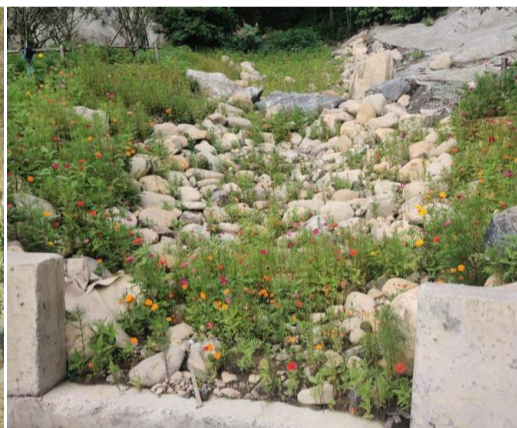
道路边坡生态排水沟
