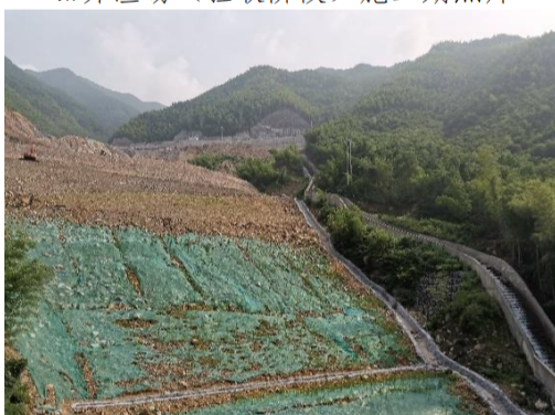
5#弃渣场（验收阶段）施工期照片
