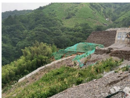
2#弃渣场（验收阶段）施工期照片
