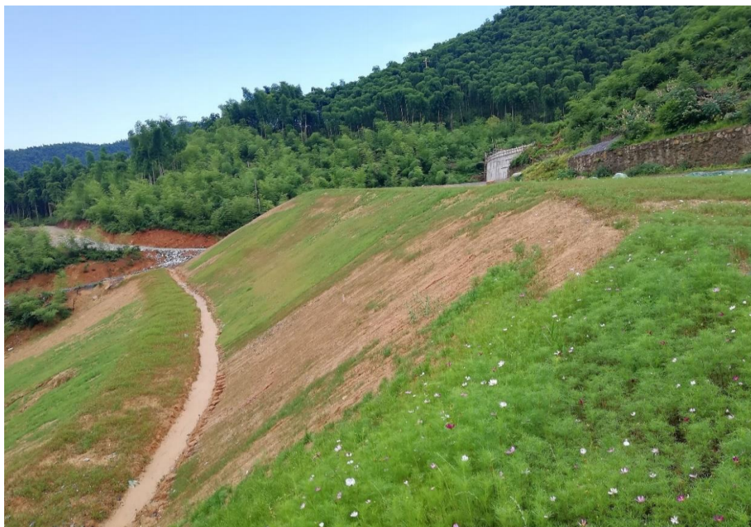
图 5.1-16 施工期银坑表土临时堆放场照片
