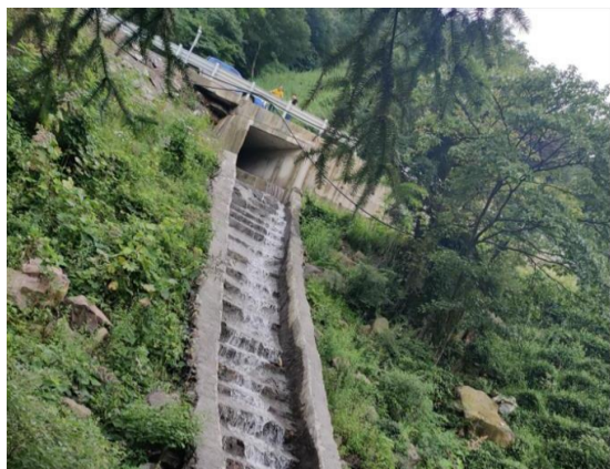
9#隧道进口排水箱涵及跌水坎
