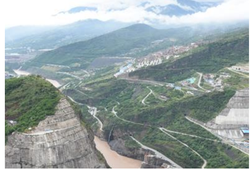
公路边坡绿化（枢纽工程区）
