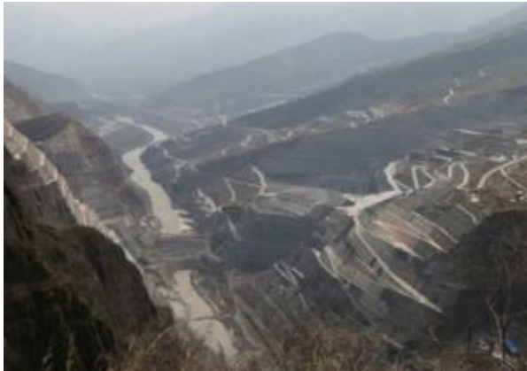
左岸场内交通
