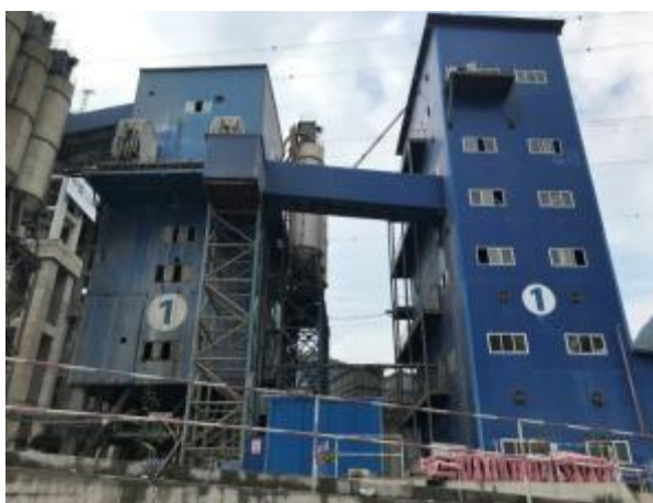
大坝低线混凝土生产系统
