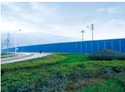
向家坝工程田坝区隔声屏障（总长度达870米）
