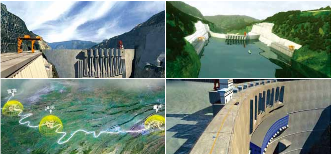
溪洛渡工程建设部制作环保专题三维动画片，通过现场照片和实景拍摄，并结合三维模拟，全面生动地展示溪洛渡工程概况、环保工作历程、环保理念、环保管理措施、环保“三同时”落实情况和环保效果等方面工作。
