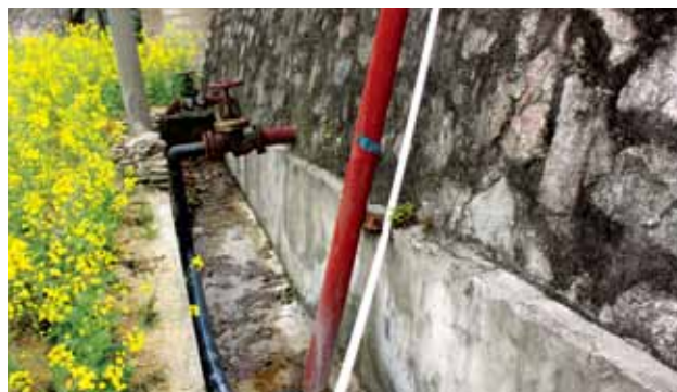
湖北宜昌市夷陵区乐天溪镇下岸溪村供水改造工程
