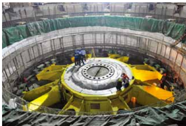
三峡工程地下电站建设
