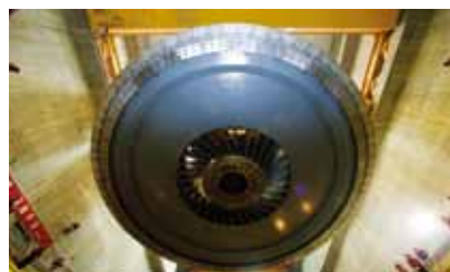
三峡工程右岸机组转子吊装
