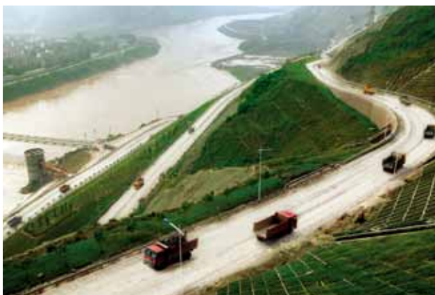
施工区边坡绿化
