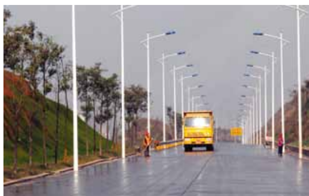
向家坝工程道路建设
