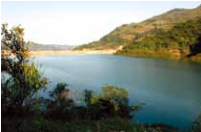
向家坝工程尾渣坝污水处理全景
