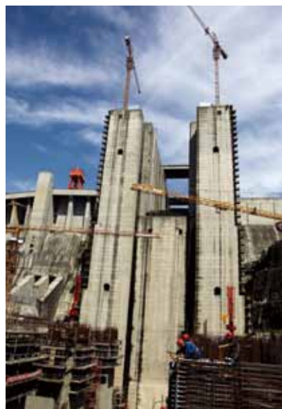
三峡工程升船机建设
