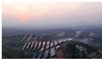
河北曲阳光伏电站
