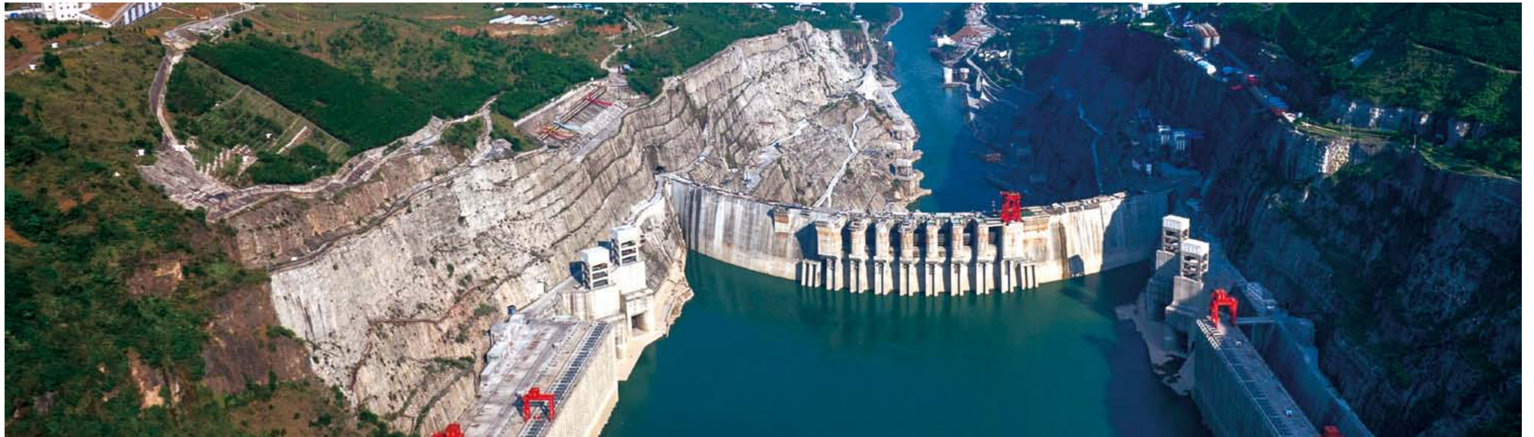
溪洛渡大坝被喻为“拱坝精品，西部典范”。溪洛渡大坝施工中的高度数字化，避免了因温度控制不当造成的大坝裂缝，在温控技术方面达到了国内行业领先水平
