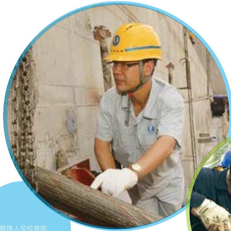
管理人员检查缆机主索安装情况
