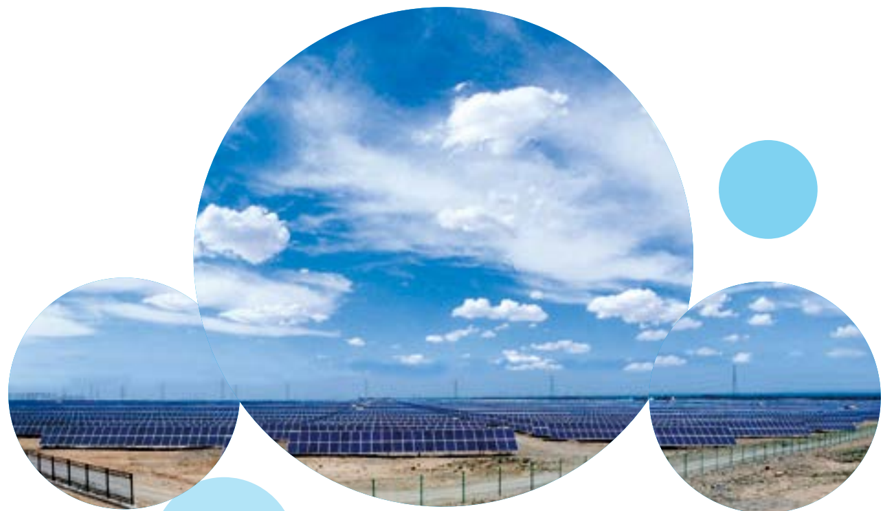
甘肃酒泉朝阳光伏电站
