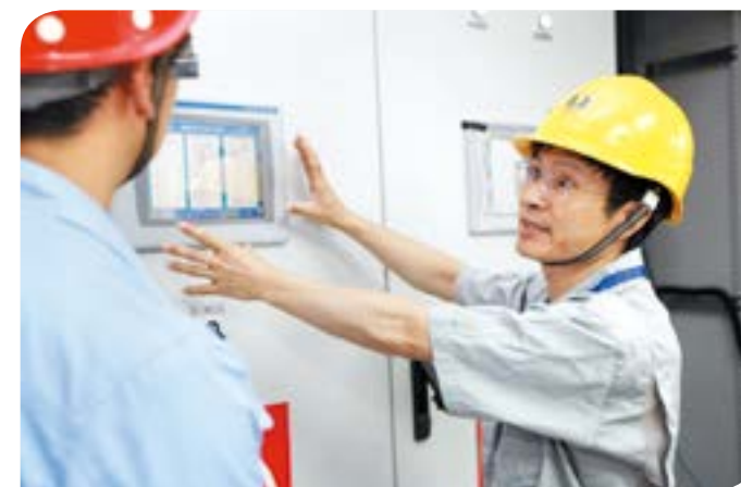
“最美三峡人”张润时在三峡升船机工程调试现场
