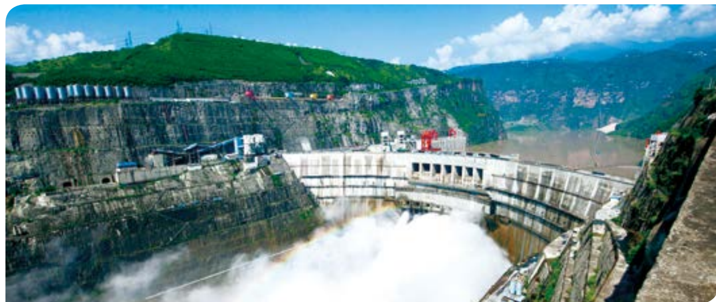
“聪明的大坝”——溪洛渡大坝
