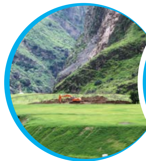
乌东德工程右岸施工期表土堆放场
