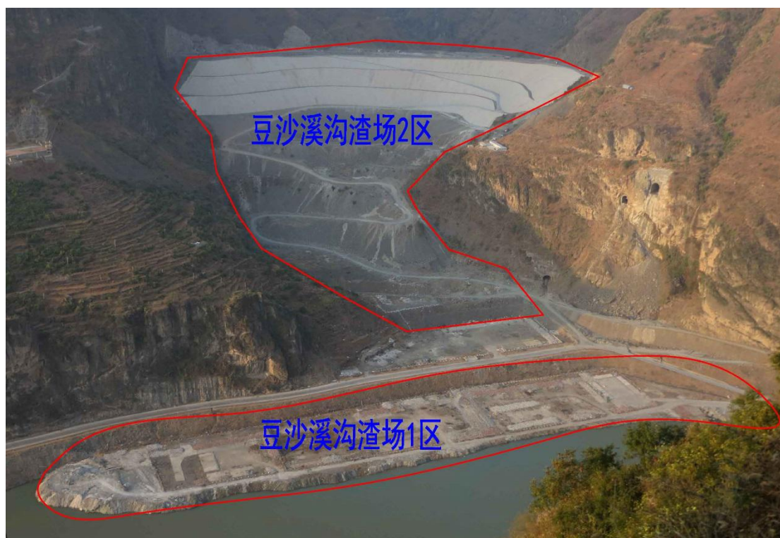
图 3.2.3-6 豆沙溪沟弃渣场施工期影像
