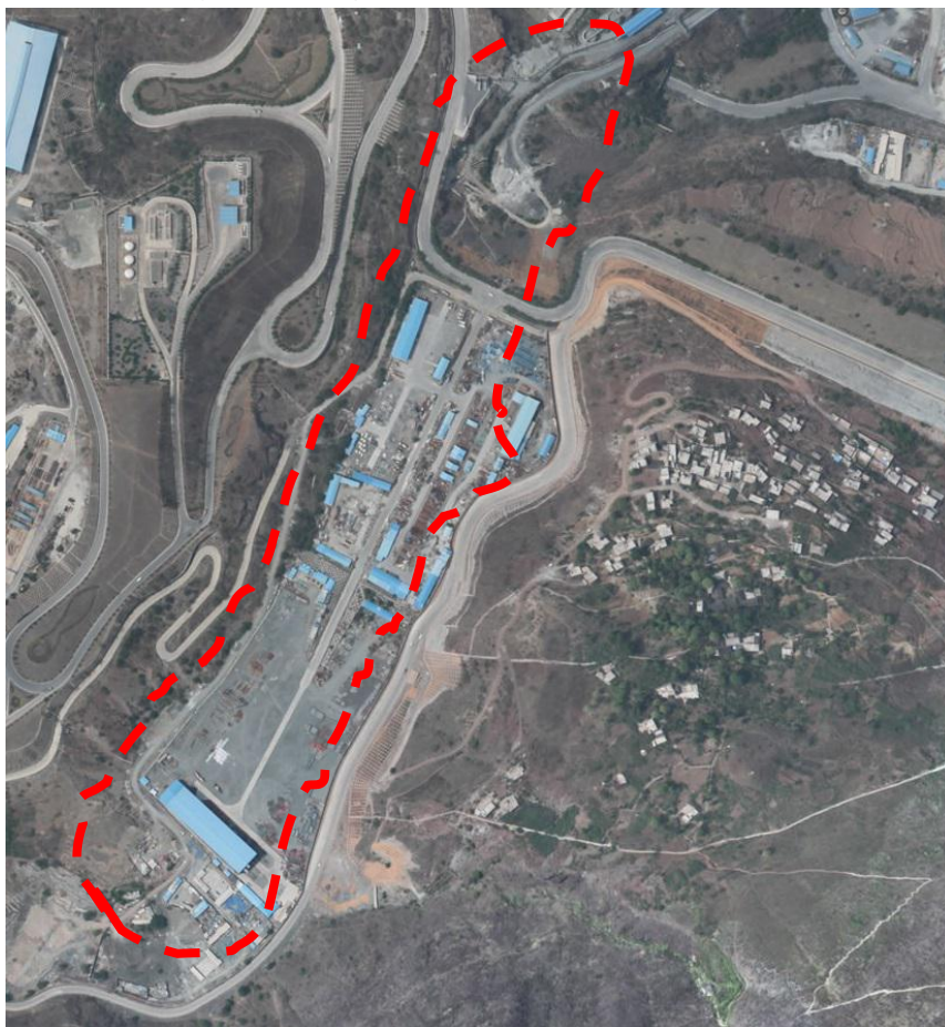
图 3.2.3-10 溪洛渡沟弃渣场施工期影像
