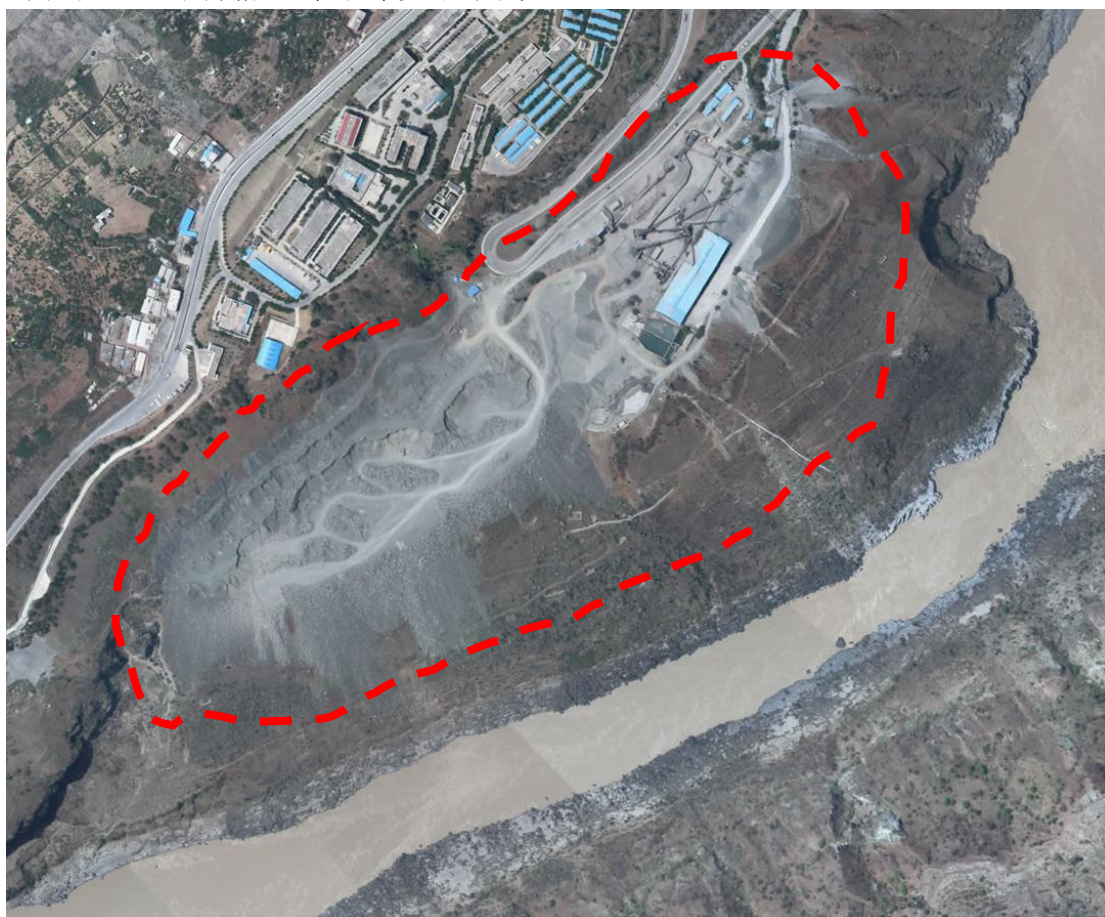
图 3.2.3-4 黄桷堡弃渣场施工期影像
