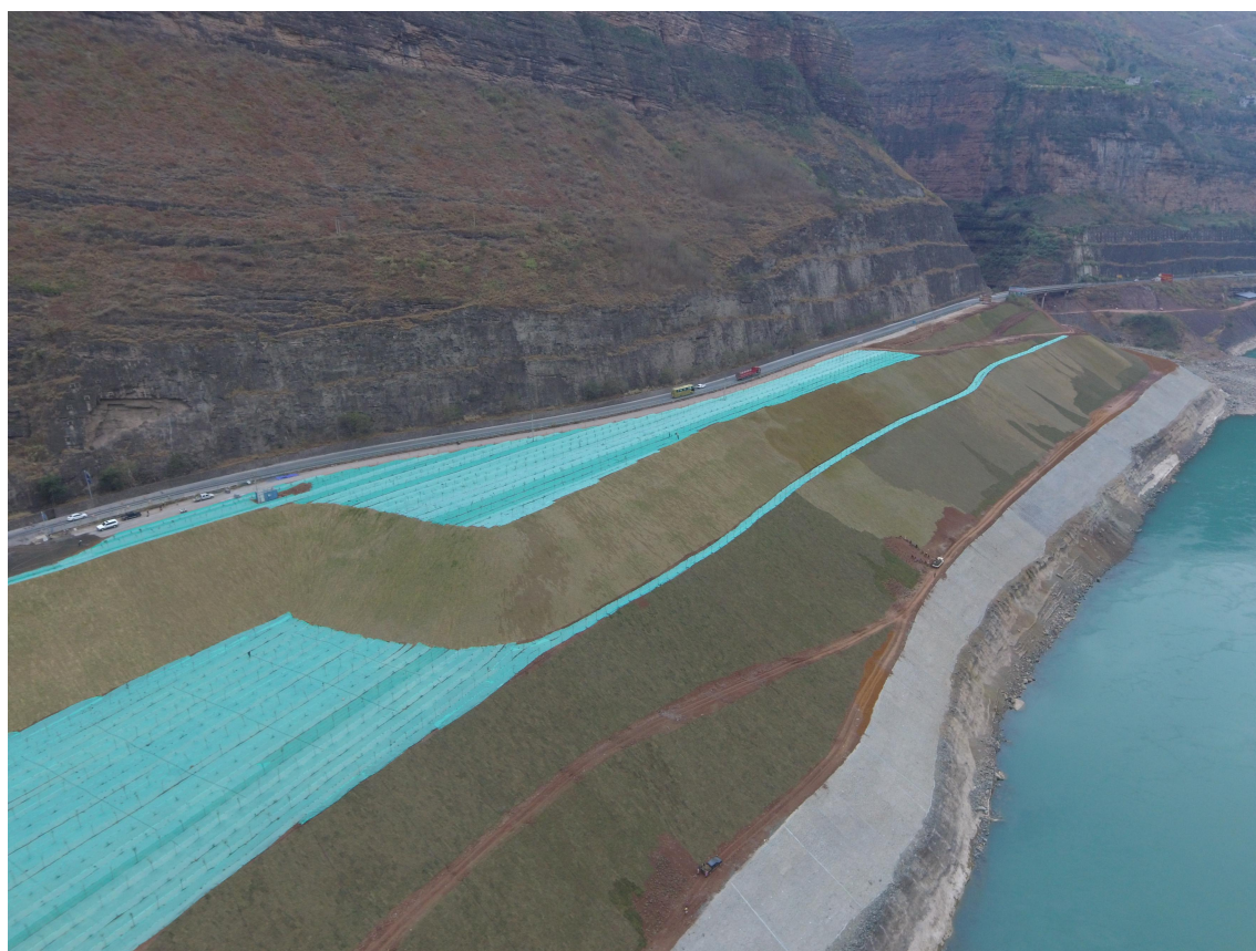
图 3.2.3-3 癞子沟弃渣场施工后影像
