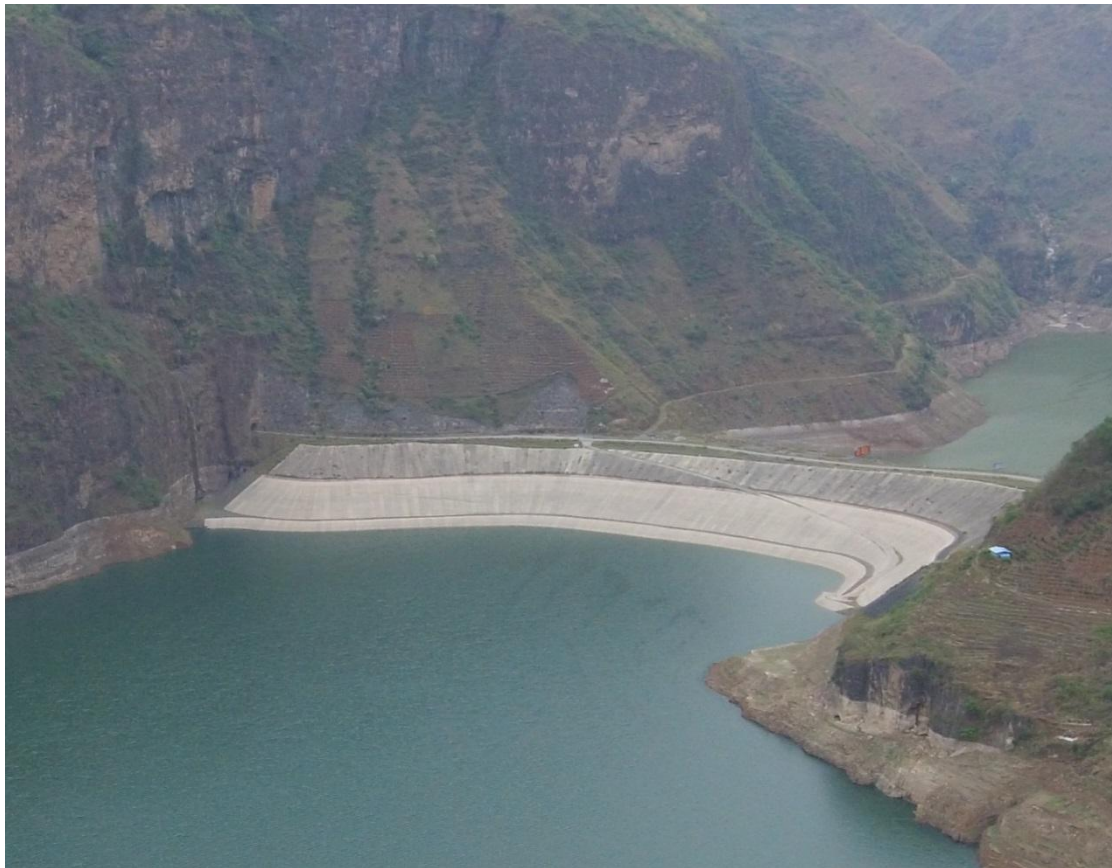
图 3.2.3-7 豆沙溪沟弃渣场施工后影像
