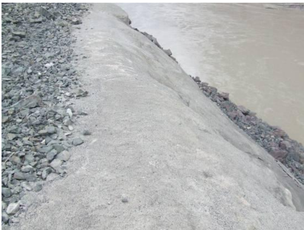
图 3.2.3-2 癞子沟弃渣场施工期临江挡墙设施影像
