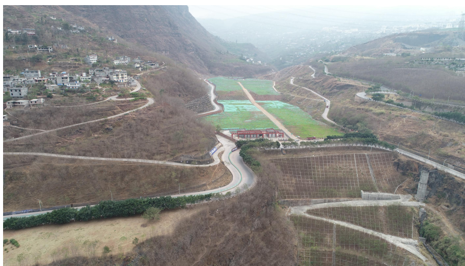
图 3.2.3-11 溪洛渡沟弃渣场施工后影像
