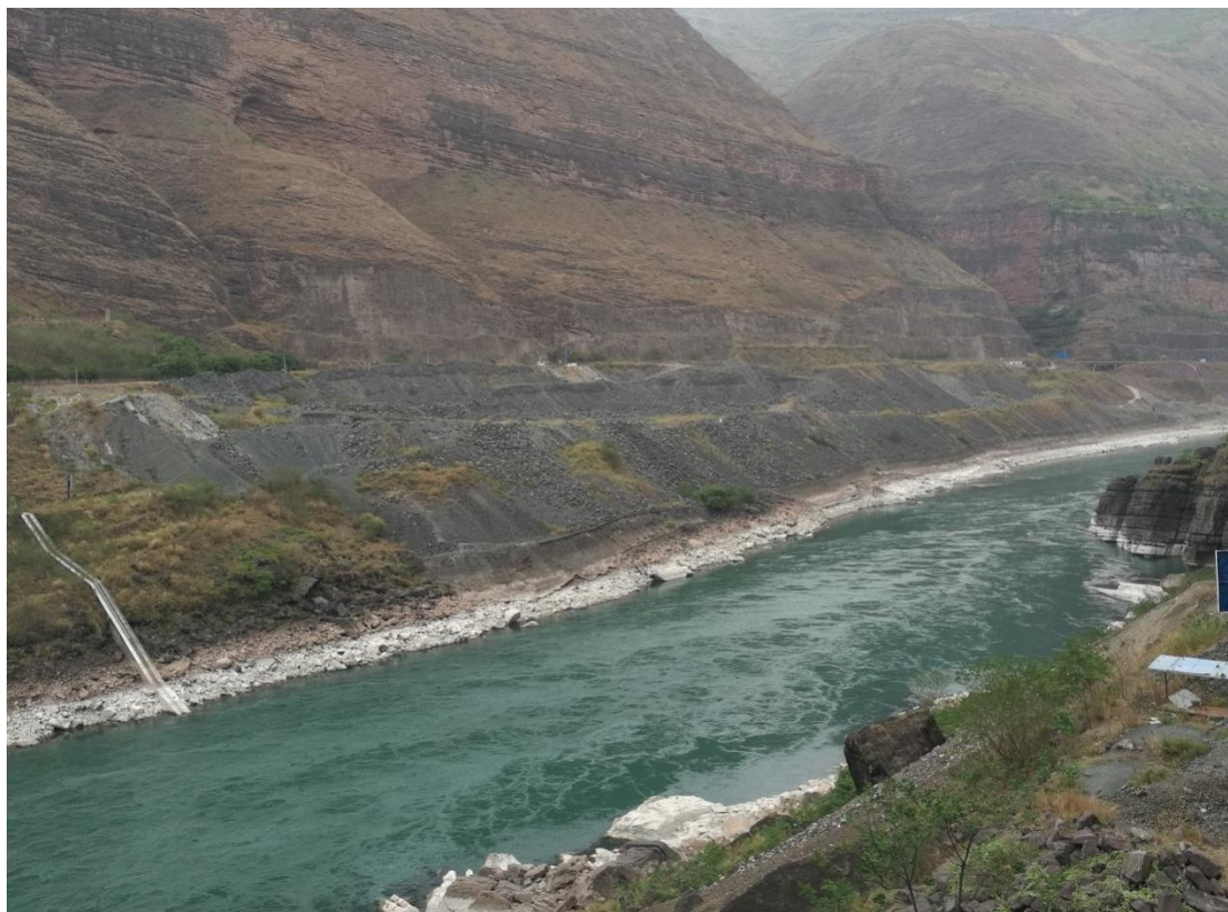
图 3.2.3-1 癞子沟弃渣场施工期影像
