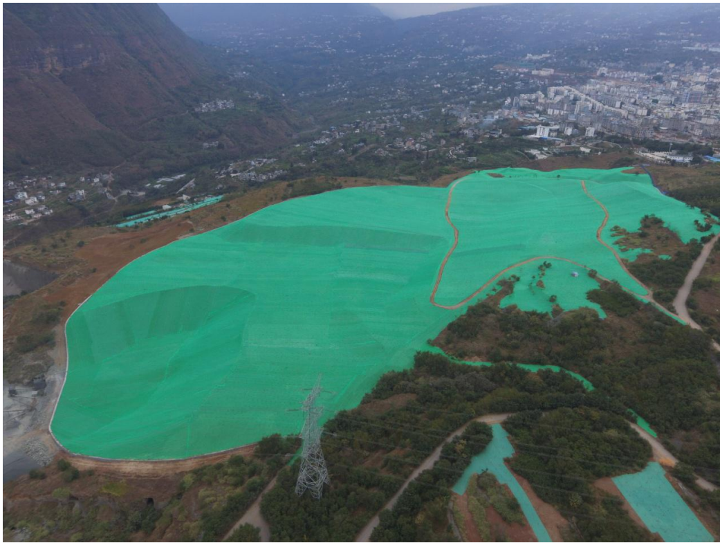
图 3.2.3-9 塘房坪弃渣场施工后影像
