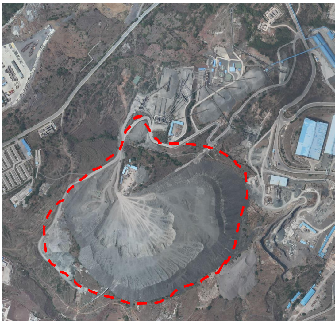
图 3.2.3-8 塘房坪弃渣场施工期影像
