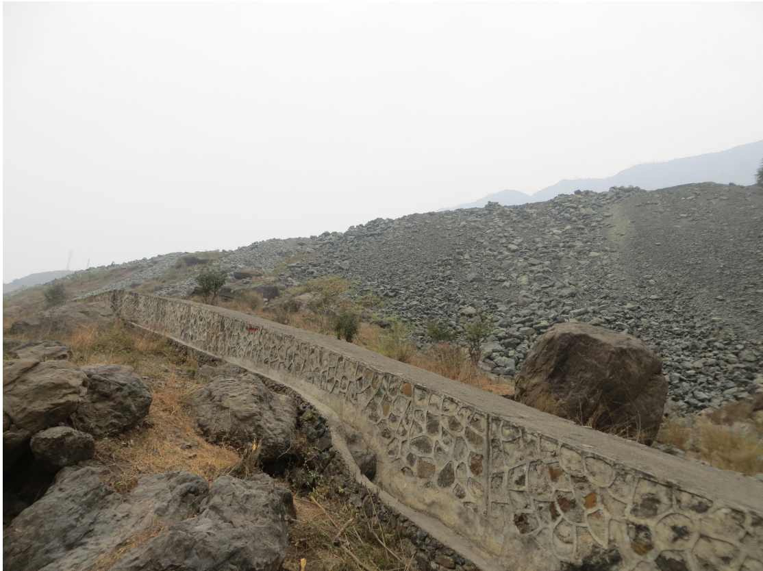
图 3.2.3-5 黄桷堡弃渣场临江挡墙施工期影像
