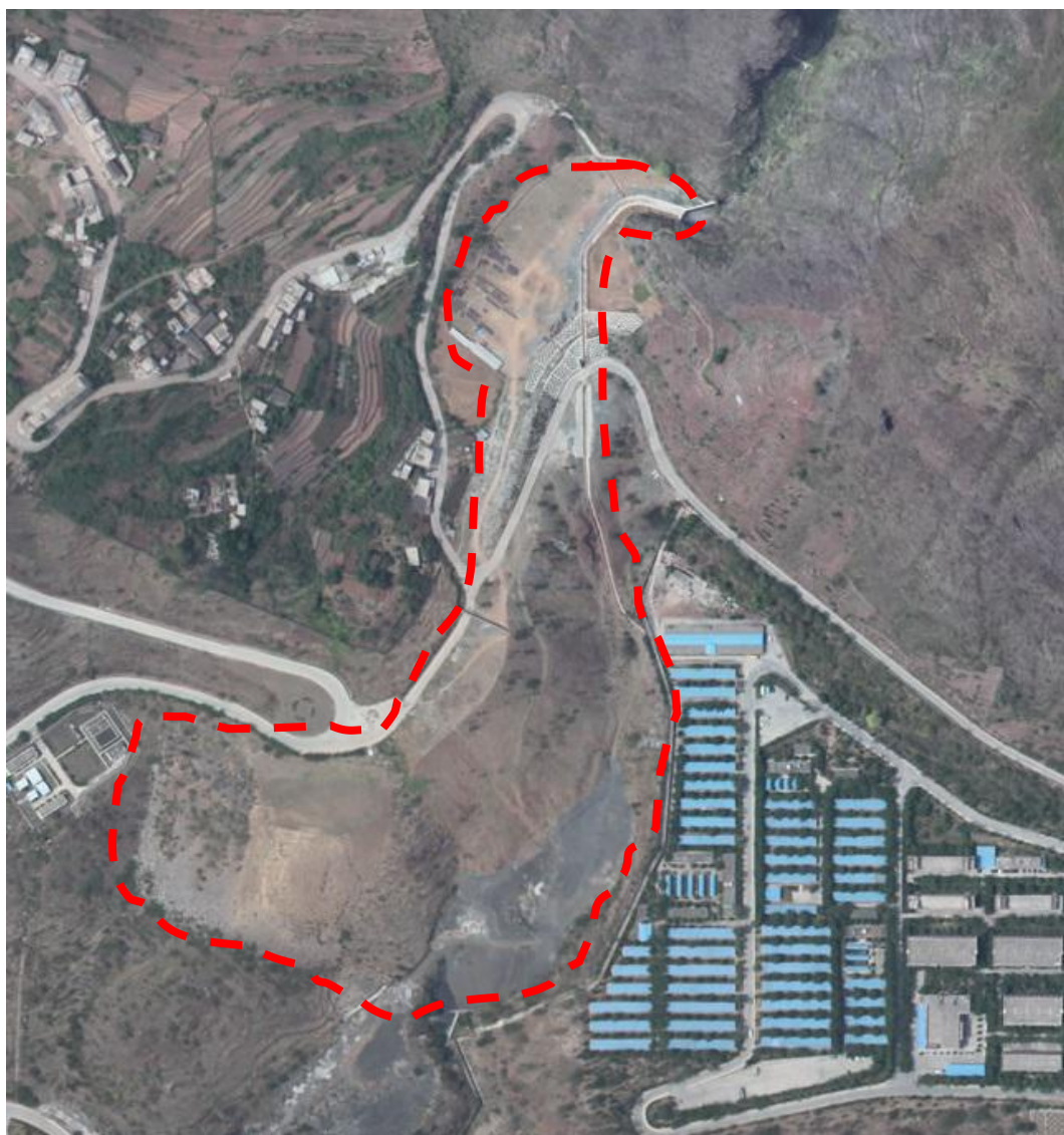
图 3.2.3-12 杨家沟弃渣场施工期影像
