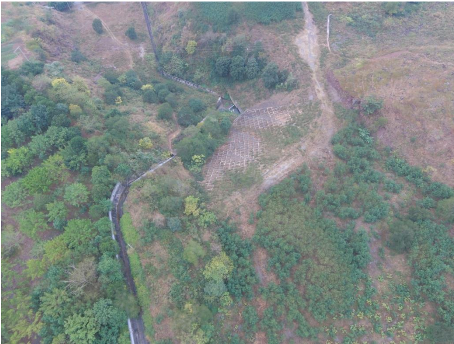
杨家沟弃渣场顶面及边坡效果
