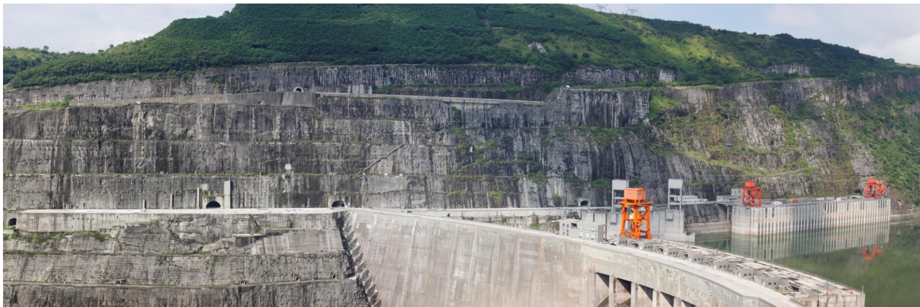
大坝右岸上游边坡
