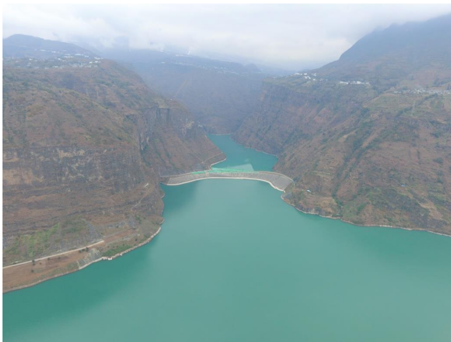
豆沙溪沟弃渣场远景
