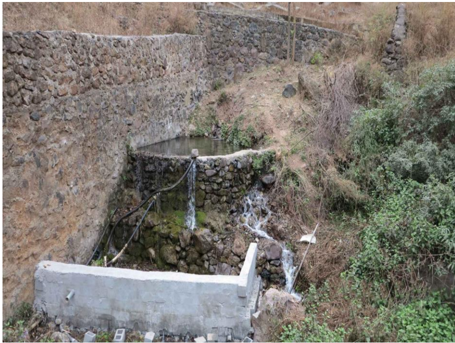
杨家沟弃渣场底部排水
