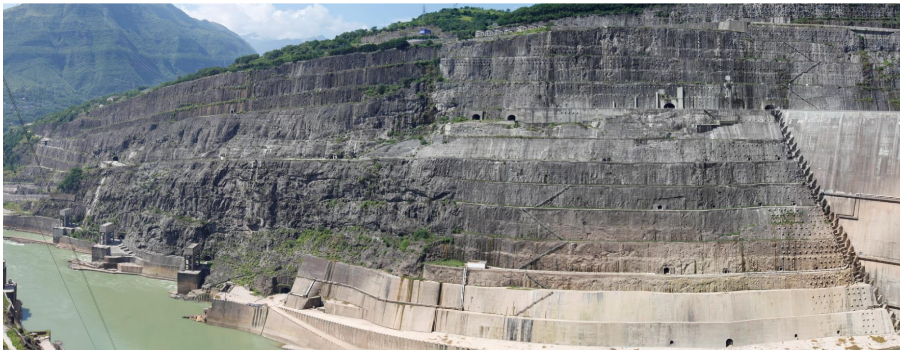
大坝右岸下游边坡
