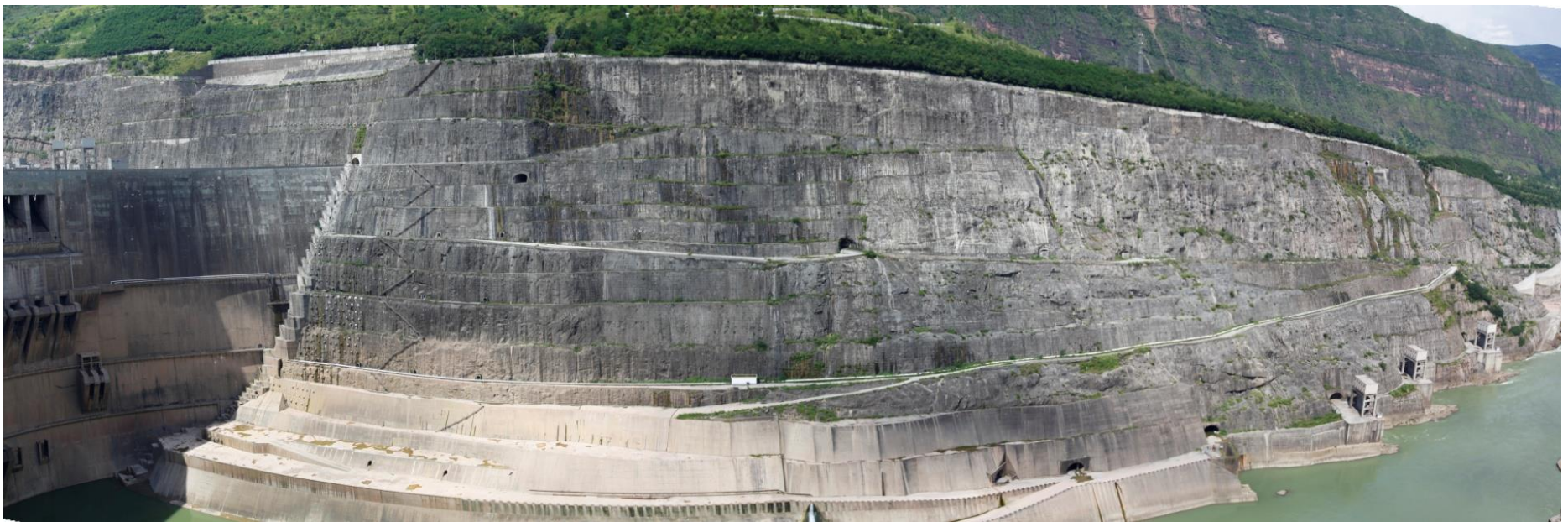
大坝左岸下游边坡
