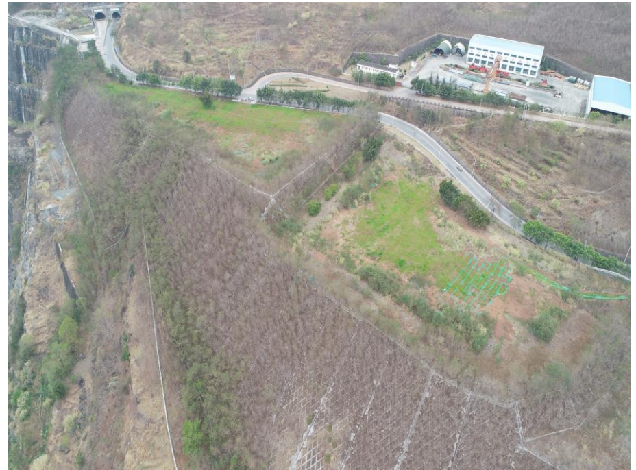
左岸七局、八局施工营地
