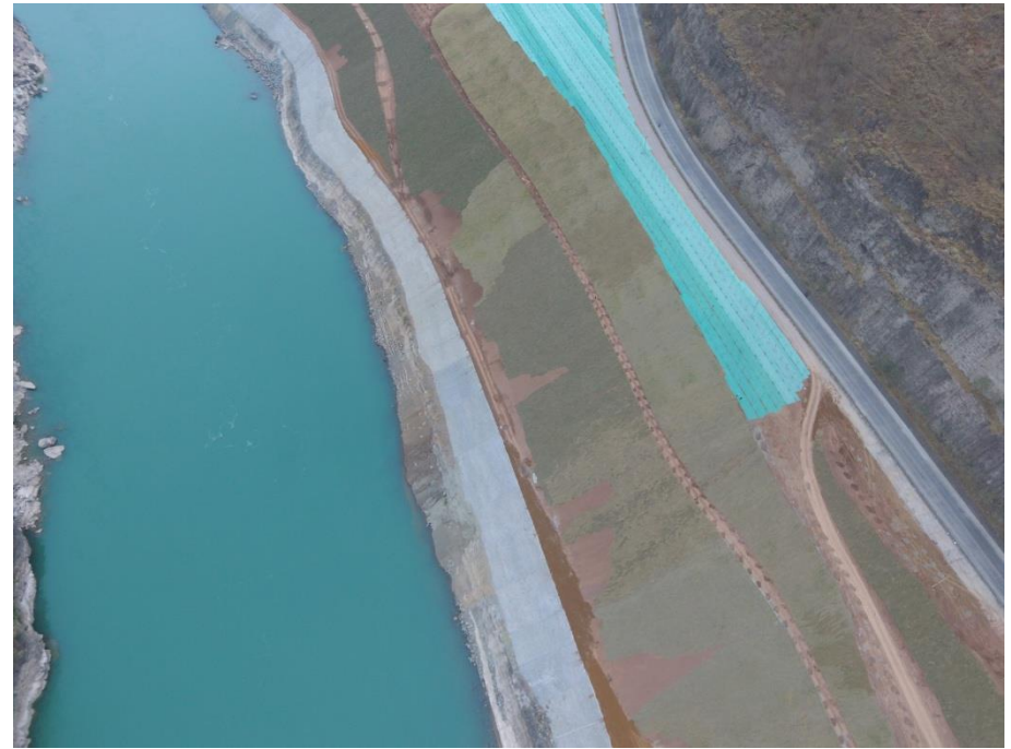
癞子沟弃渣场边坡浆砌石护坡+铺草皮绿化
