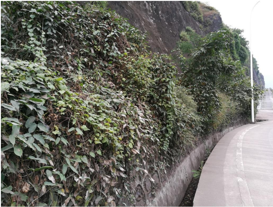
道路边坡混凝土喷护护坡
