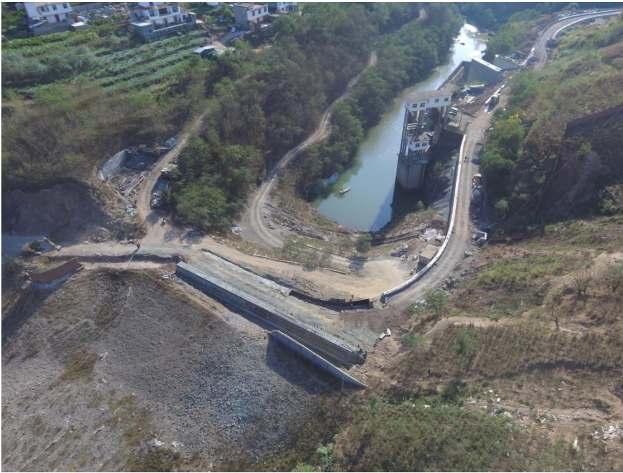
溪洛渡沟弃渣场上游挡水坝位置，目前已被遮盖
