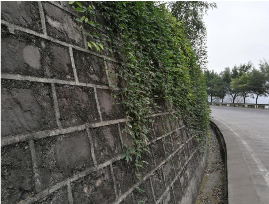
道路路堑挡土墙绿化
