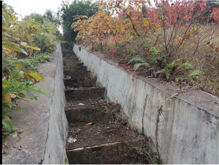
施工生产生活区防洪排导措施
