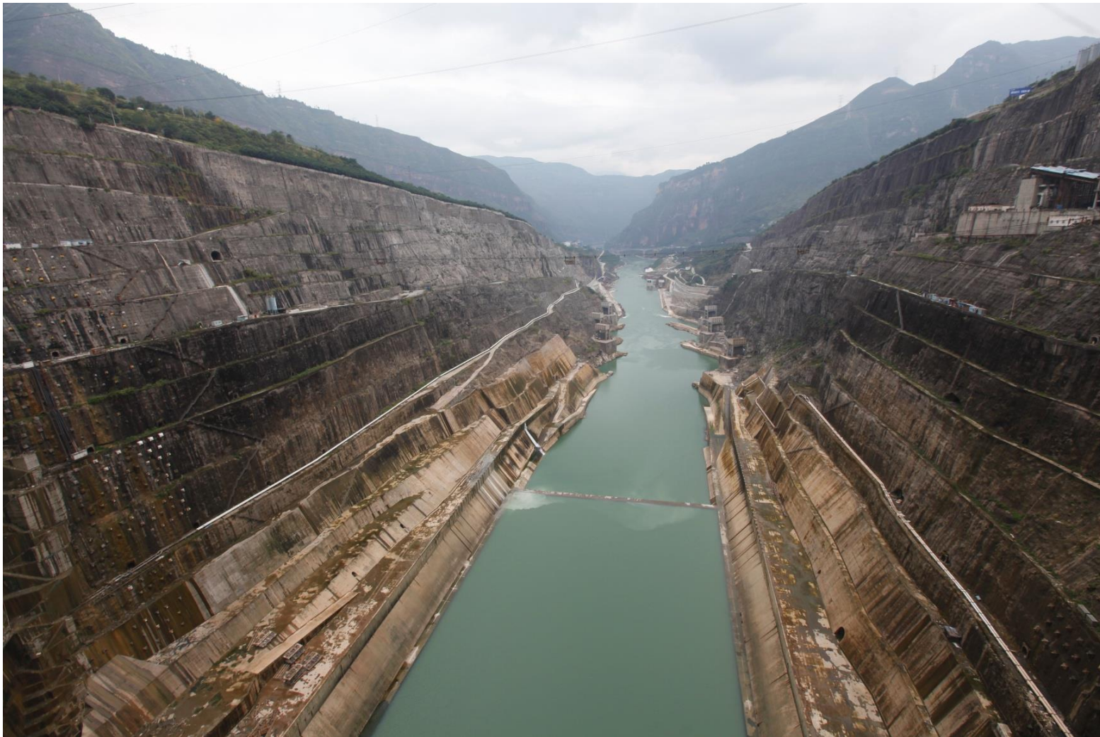
大坝下游两岸边坡
