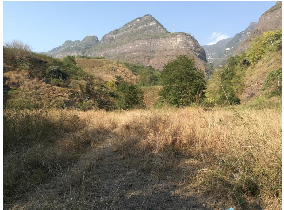
杨家沟弃渣场底部平台绿化
