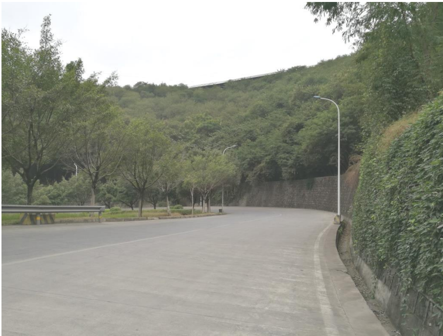
边坡网格梁护坡
