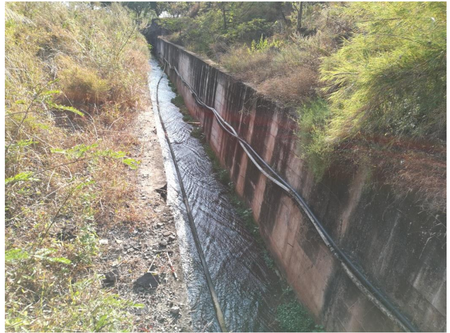
杨家沟弃渣场下游排水渠细部
