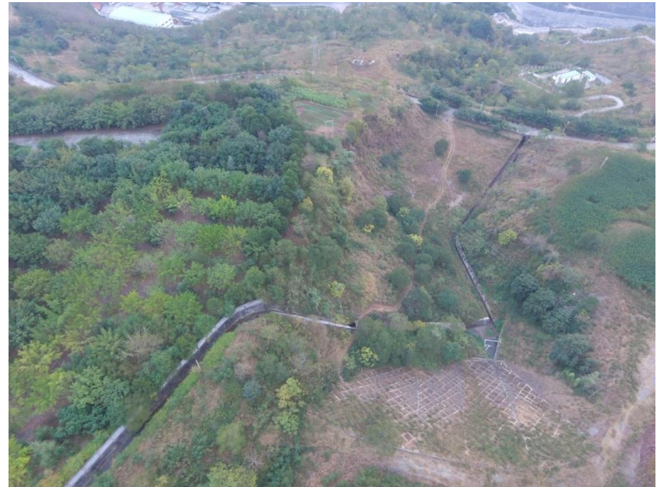
杨家沟弃渣场下游边坡网格梁，沟道左岸排水明渠
