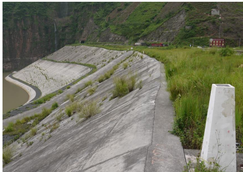
豆沙溪沟弃渣场近景
