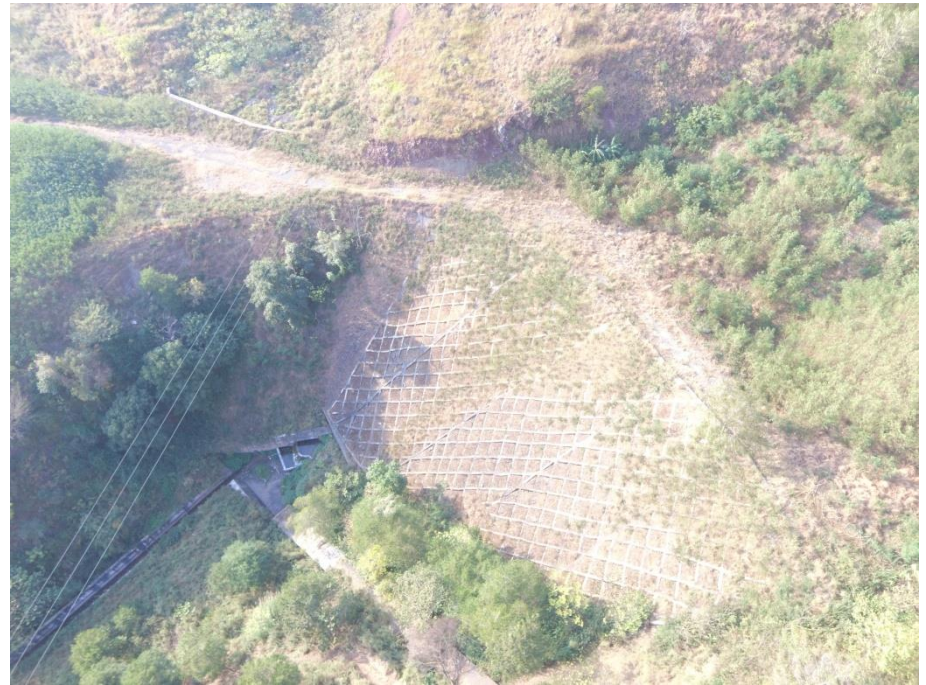
杨家沟边坡网格梁植草绿化
