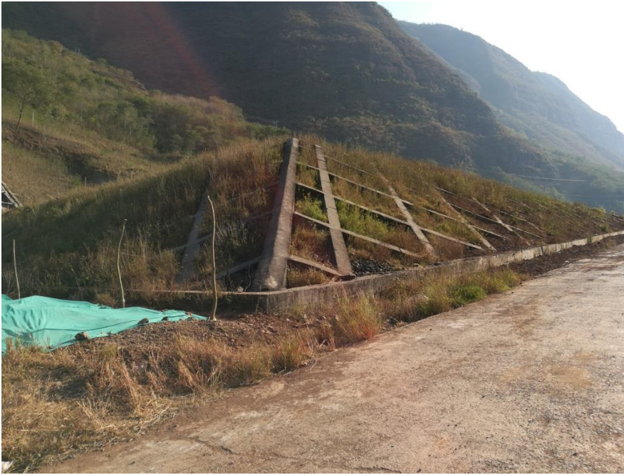
溪洛渡沟弃渣场网格梁植草护坡
