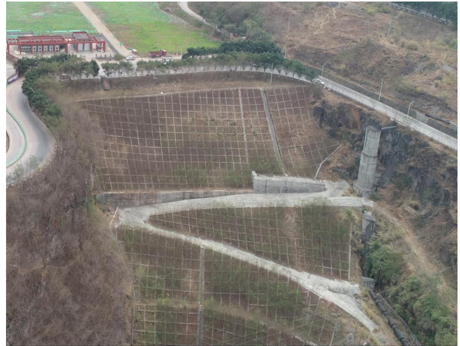
溪洛渡沟弃渣场边坡排水沟、挡墙
