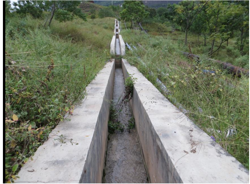
施工生产生活区防洪排导工程
