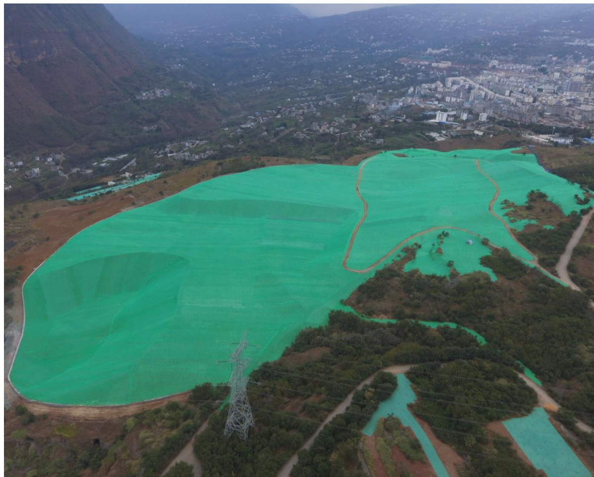
塘房坪弃渣场全景
