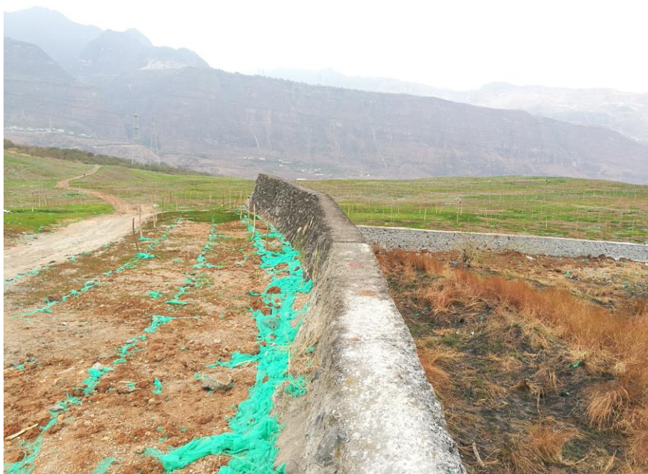
塘房坪弃渣场原有挡墙
