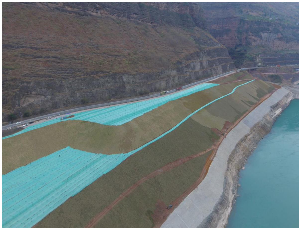
懒子沟弃渣场远景
