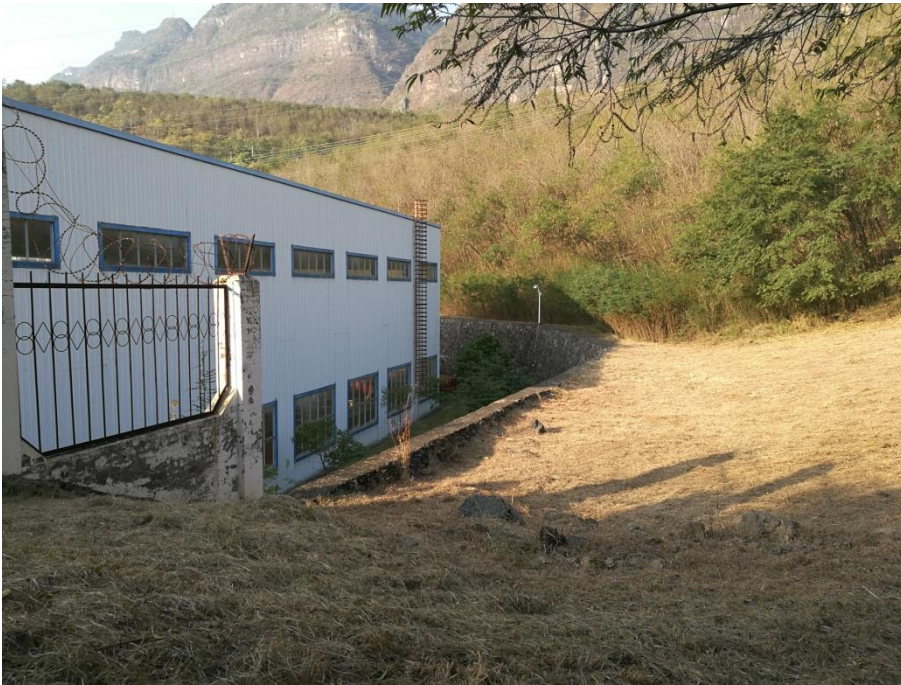
网格梁植草护坡
