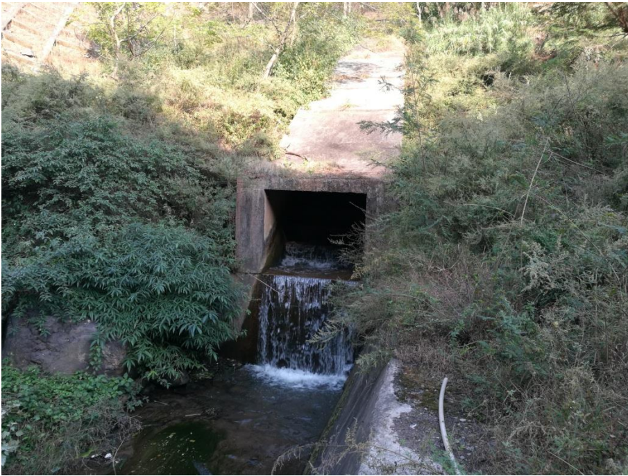
杨家沟弃渣场左岸坡面排水箱涵
