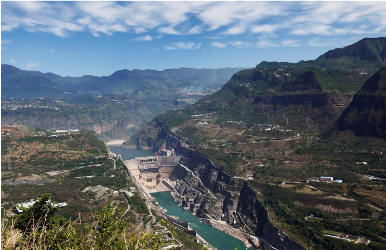
大坝全景(远景)
