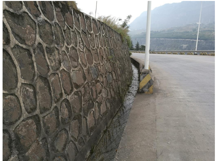
永久道路内侧排水沟
