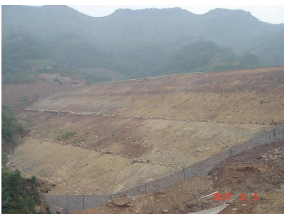
尾渣坝下游边坡
