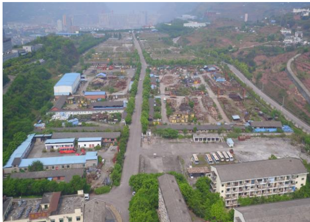
莲花池片区施工营地
