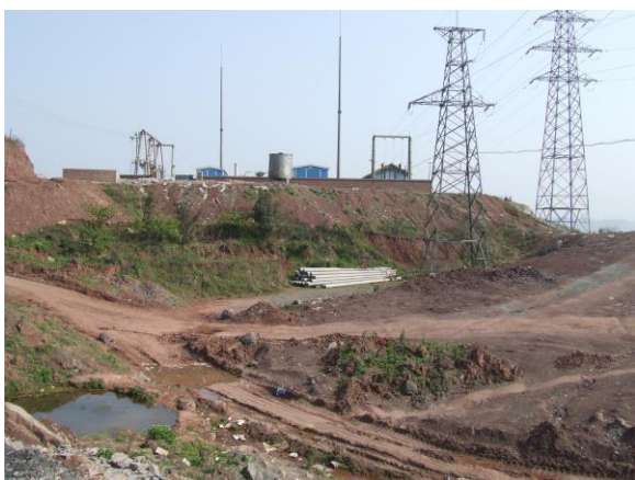
左岸 35kv 变电站
