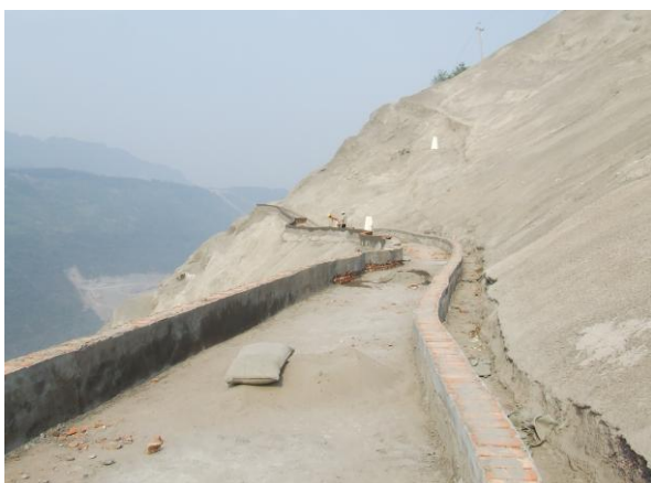
缆机平台高边坡
