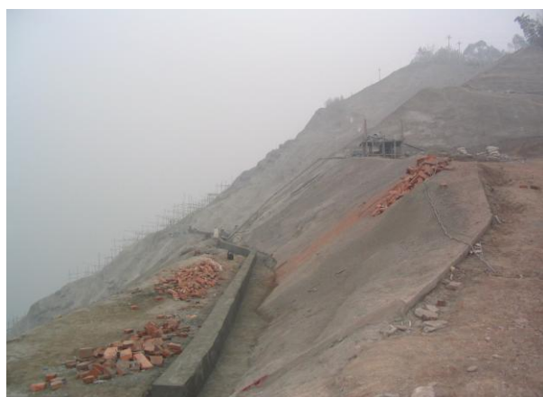
左岸缆机平台
