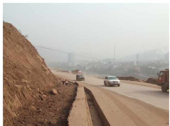
左岸进场公路
