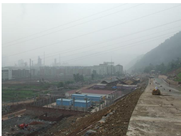
右岸田坝变电站边坡
