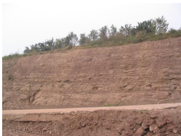
进场公路边坡
