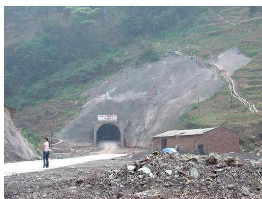
隧洞出口顶部护坡及截排水沟
