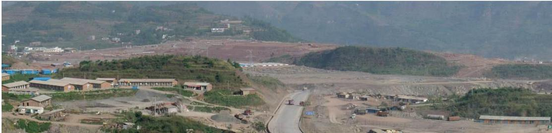
莲花池位于坝址下游 2.1—4.5km 处，可利用面积约 150hm<sup>2</sup>。堆填渣成分主要为砂岩和砂砾石，堆填方式采用自下而上分层填渣，卸渣经机械碾压整平后，渣体内角为 33°--42°，堆渣表面高程为 360m—408m。
