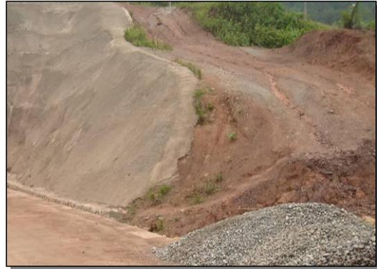
9号隧洞进口顶部边坡水土流失
