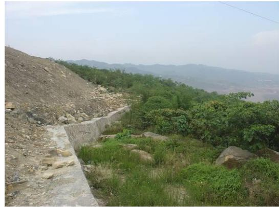
110kv 变电站坡面堆渣高过挡墙
