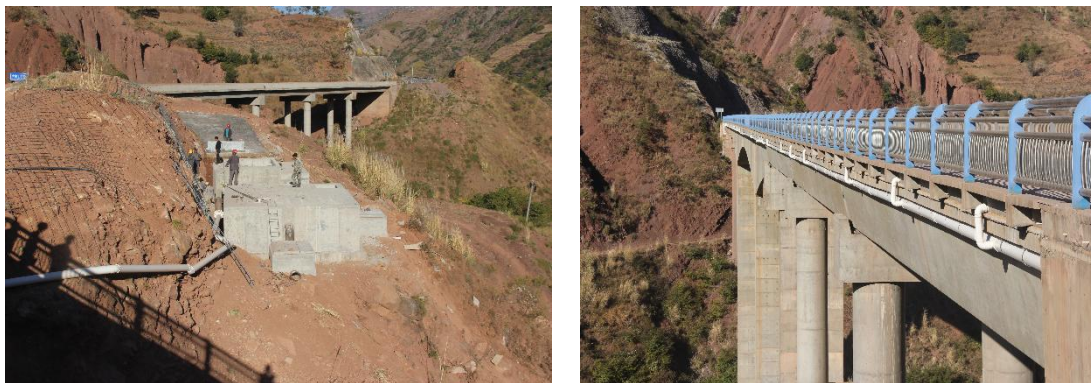
桥面径流收集系统和桥下事故池
