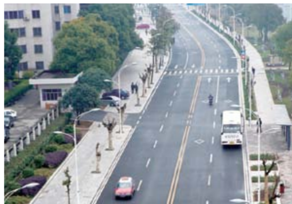
改造后的葛洲坝上坝公路
