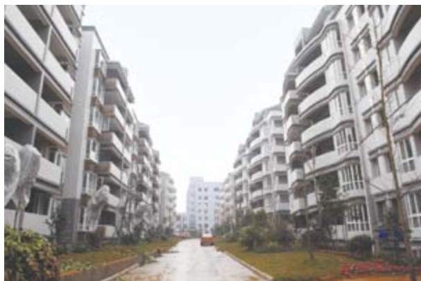
四川屏山新县城移民小区
