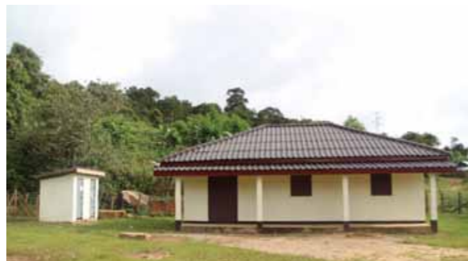
老挝南椰 2 水电站项目部将修建完毕的 Nahor 村办公室移交给川广省勐昆县政府。办公室建筑面积约 80 平方米，将成为村民委员会新的办公地点。
