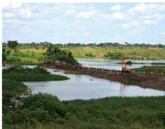
乌干达伊辛巴水电站项目
