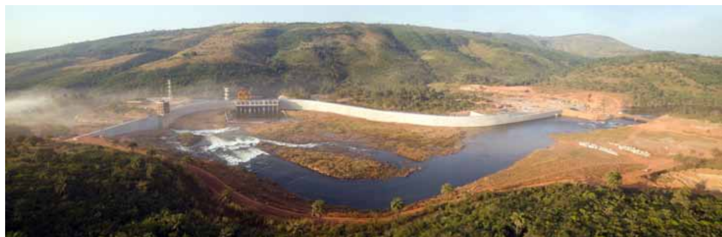
几内亚凯乐塔水利枢纽项目（EPC）
