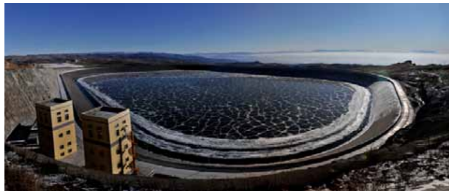
呼和浩特抽水蓄能电站上水库。11 月 10 日，首批机组按期投产发电。呼蓄电站是内蒙古自治区第一座大型抽水蓄能电站，也是公司第一个抽水蓄能电站
