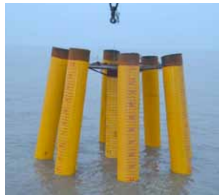
公司首个海上风电项目响水近海 20 万千瓦项目开工建设
