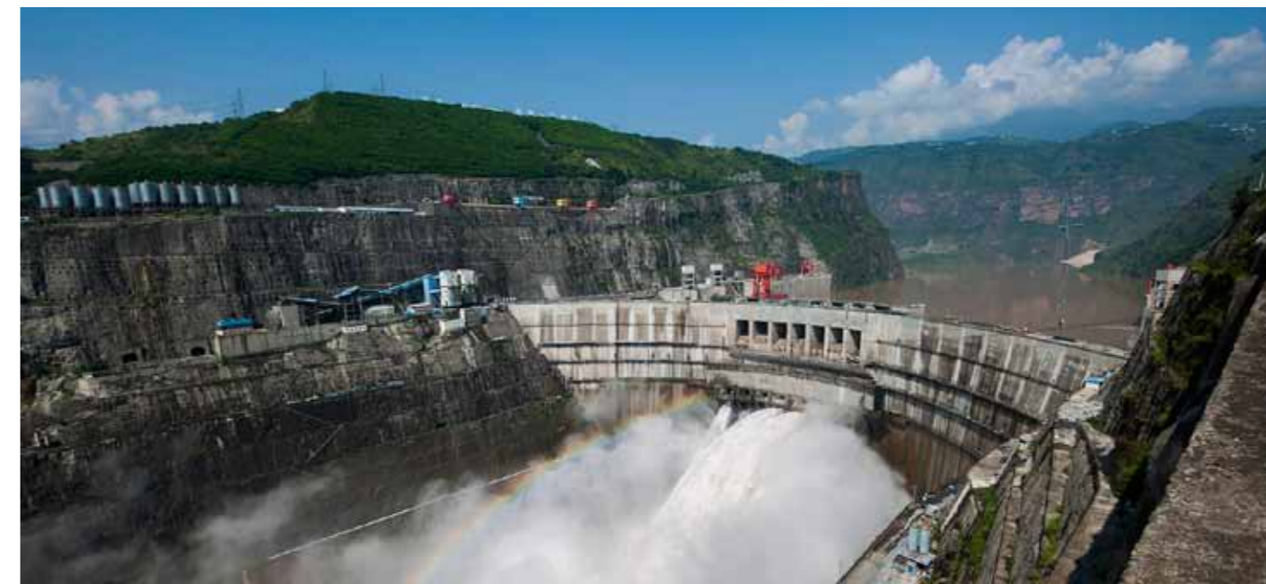
2014年，溪洛渡电站、向家坝电站成功蓄水至正常蓄水位，经受高水位运行和泄洪消能考验，水工建筑物运行性态正常，水库岸坡总体稳定
