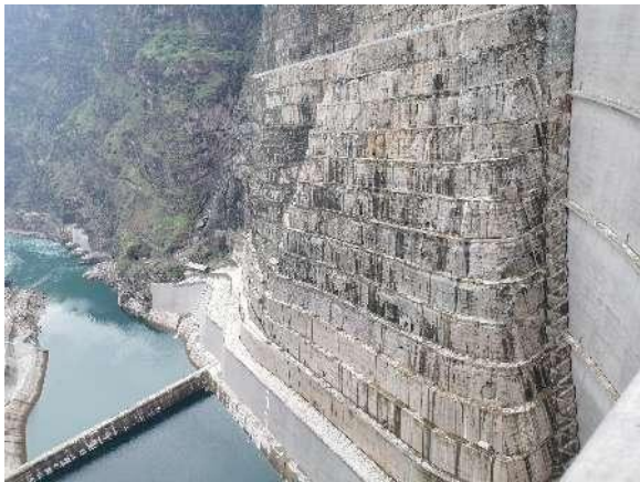
大坝工程两侧喷锚支护
