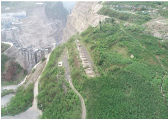
下红岩滑坡体抗滑桩植被覆盖
