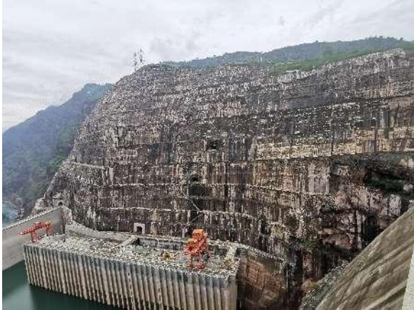
右岸边坡喷锚支护
