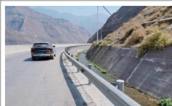
左岸高线公路植被护坡，框格梁护坡
