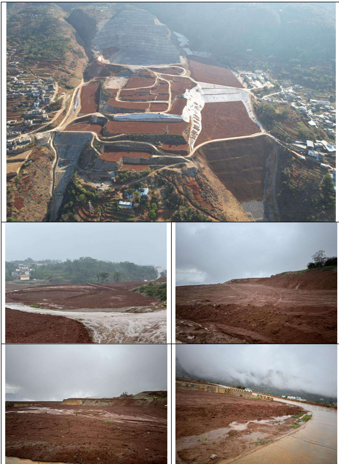
旱谷地弃渣场、旱谷地砂石加工系统区域：(1) 旱谷地砂石加工系统区域进场道路已实施排水沟堵塞、不能顺接；(2) 已落实的植物措施成活率、覆盖率不达标。
