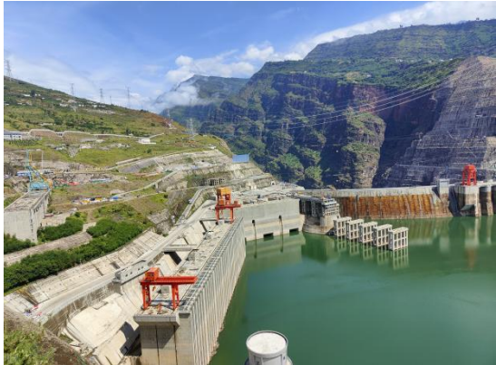
下游坝下消能池、二道坝边坡防护
