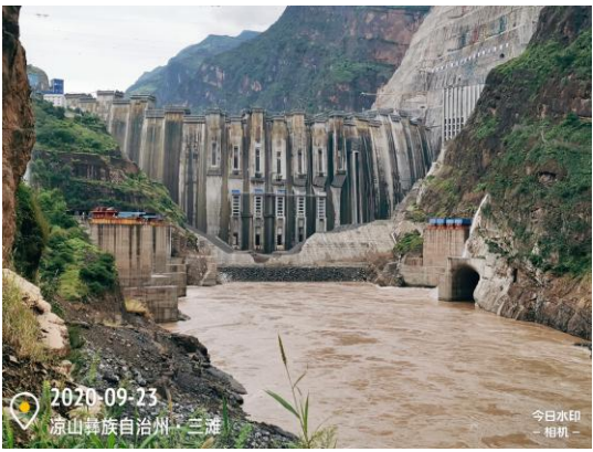
导流洞临江坡面防护
