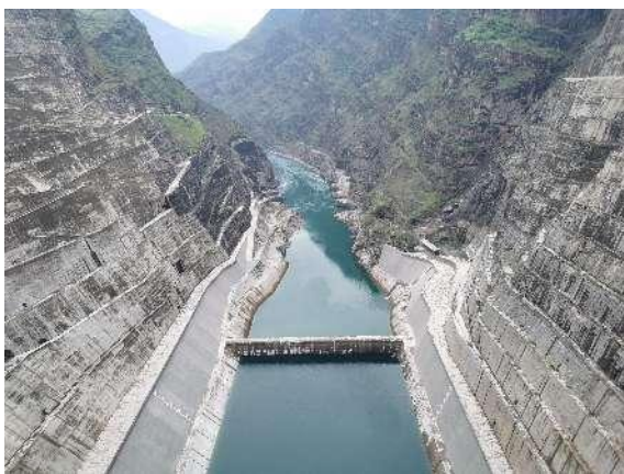
下游坝下消能池、二道坝边坡防护
