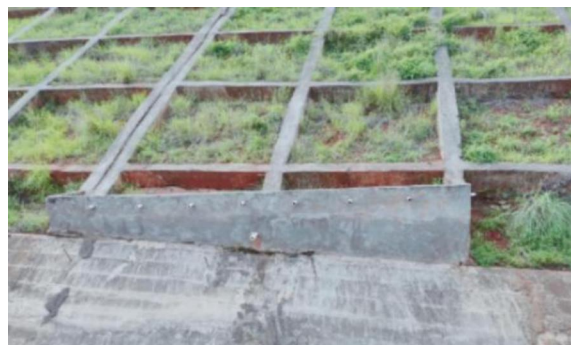
坝区整治左岸边坡径流小区监测点
