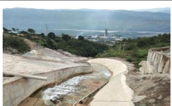
旱谷地石料生产区下游边坡喷浆护坡
