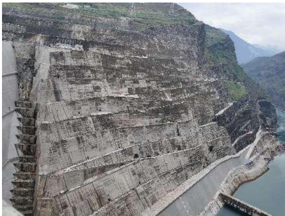
左岸边坡喷锚支护
