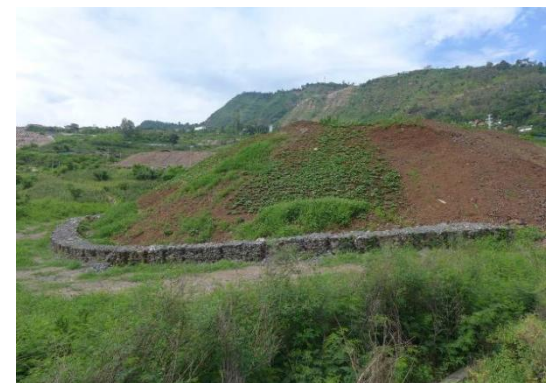
海子沟表土堆存场钢筋石笼挡护
