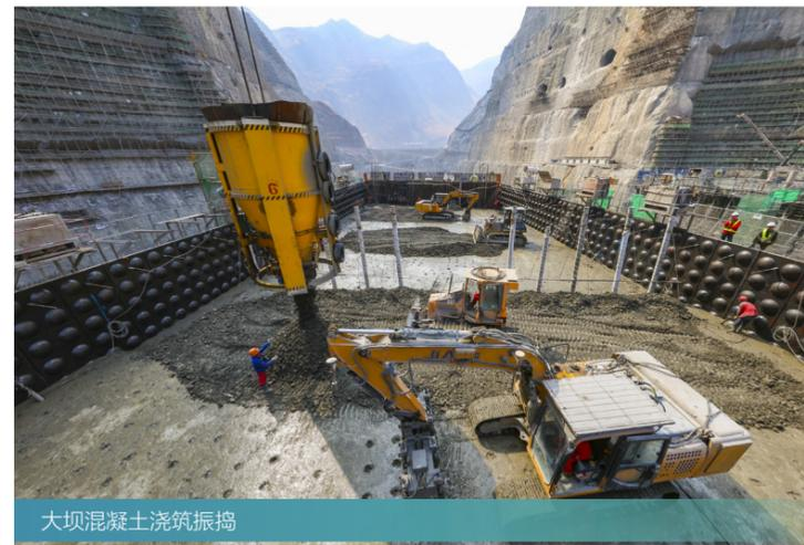
大坝混凝土浇筑振捣
