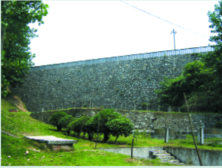
(a)生活垃圾填埋场挡墙
