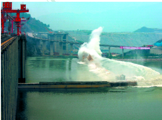
(b)RCC围堰爆破成功
