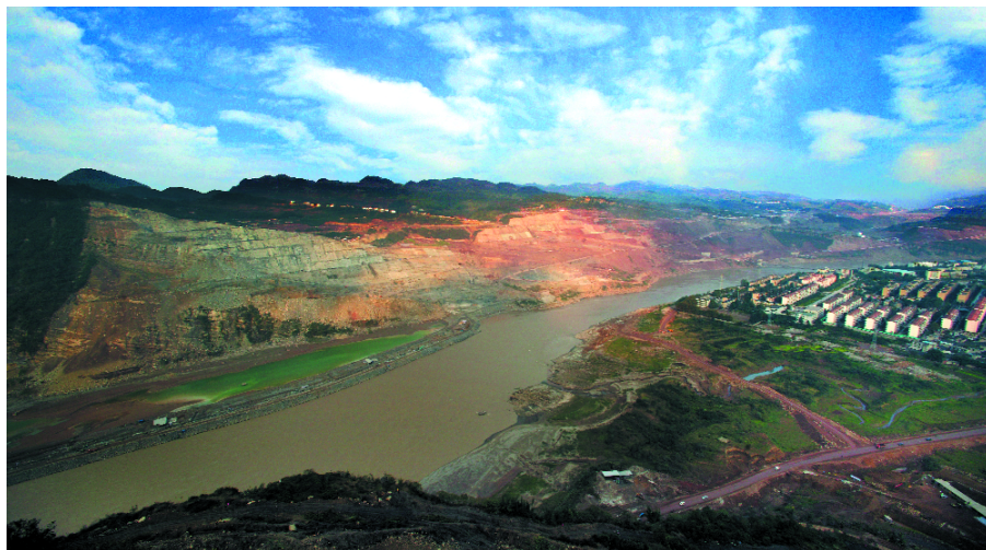
向家坝水电站施工现场全景图
