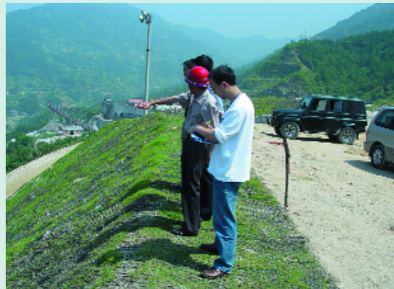
下岸溪料场边坡监理
