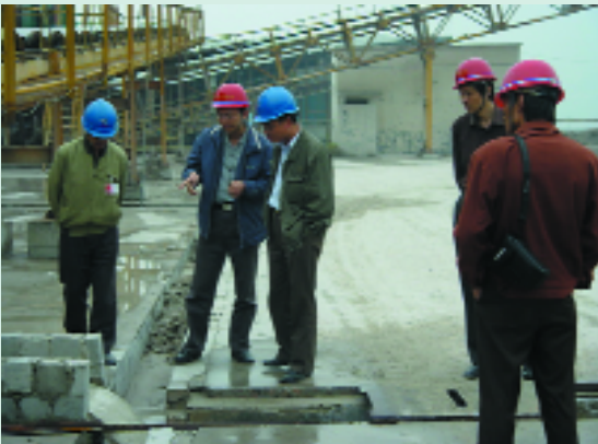
施工废水排放监理
