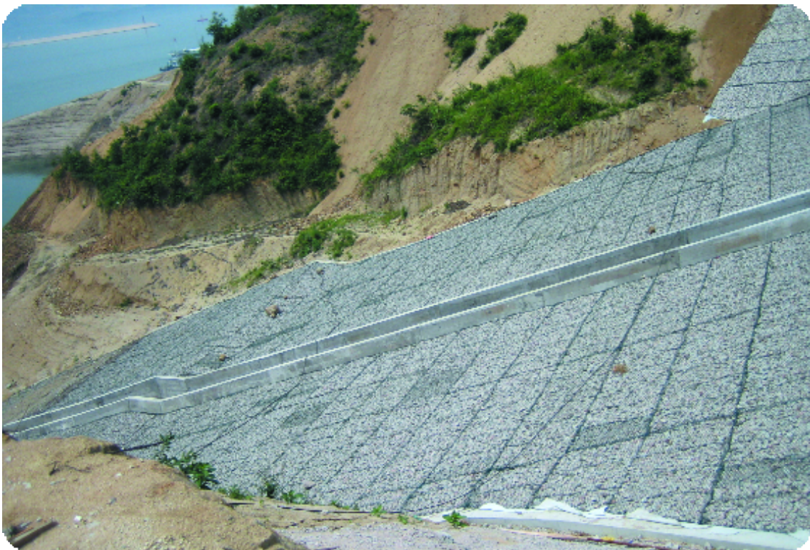
(d)库首岸边钢筋石笼护坡
