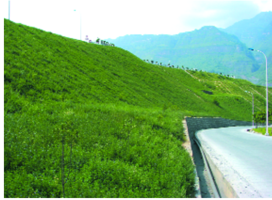
施工区公路边坡绿化工程
