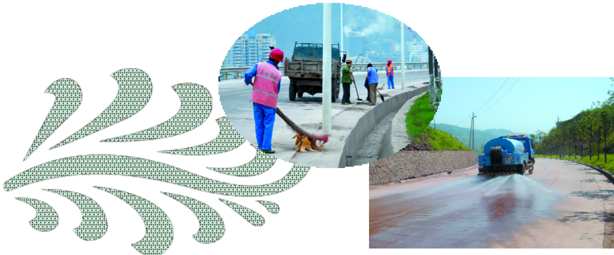
施工区道路除尘保洁
