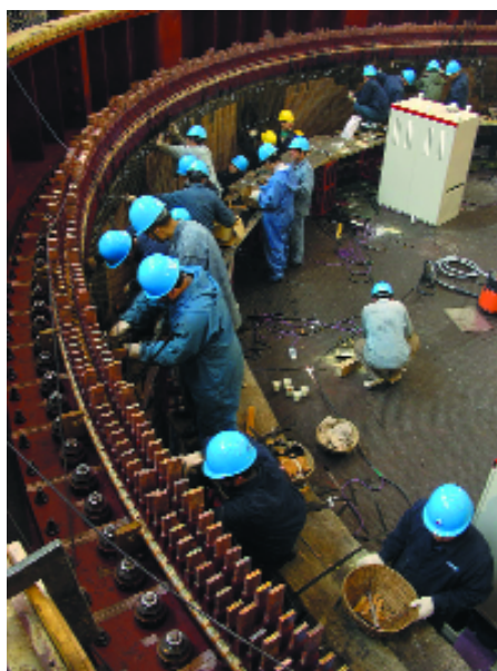
水电站绿色检修作业现场
