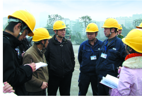
施工现场环境监理
