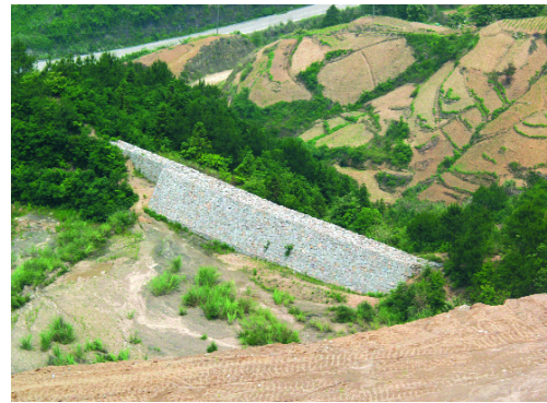
龙窝渣场挡渣墙
