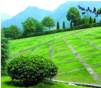
(a)边坡网格梁植草护坡
