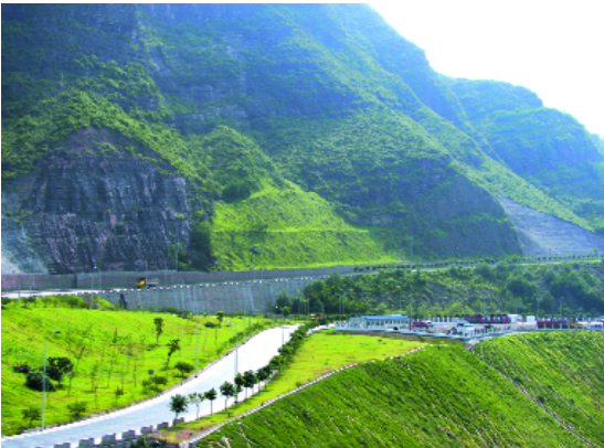
永久大桥右岸桥头绿化
