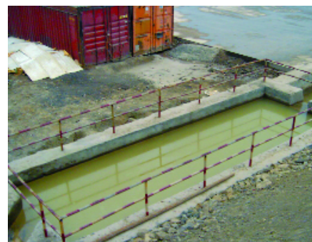
(d)左岸303m(高程)混凝土拌和楼生产废水处理
