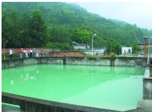
84混凝土拌和系统废水处理系统
