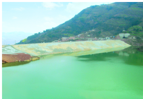
马延坡砂石骨料加工系统废水沉淀池（尾渣库）
