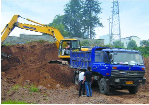
向家坝施工区表土资源回采
