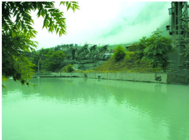
溪洛渡中心场砂石骨料废水处理系统
