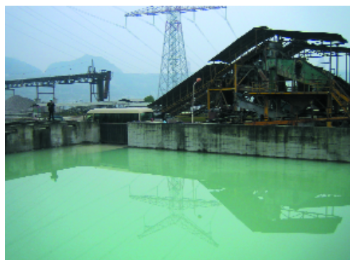
84混凝土拌和系统废水处理系统
