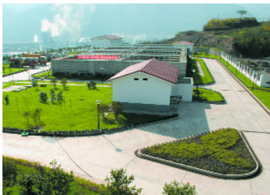
向家坝工程左岸生活污水处理厂
