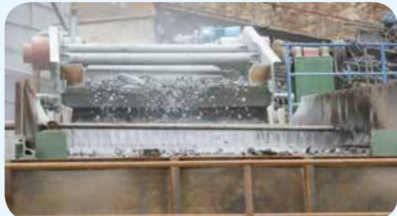
乌东德工程 850 混凝土系统湿法生产
