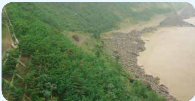
溪洛渡工程施工区坡面绿化措施
