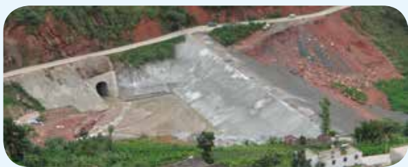
白鹤滩工程海子沟挡水坝及排水洞
