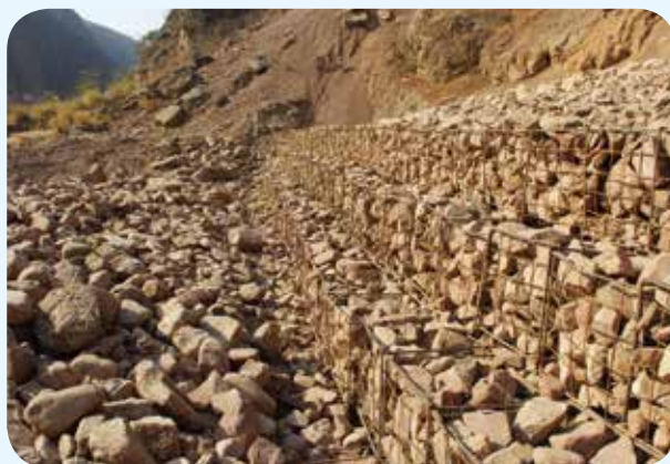
乌东德工程看阴地沟渣场挡护
