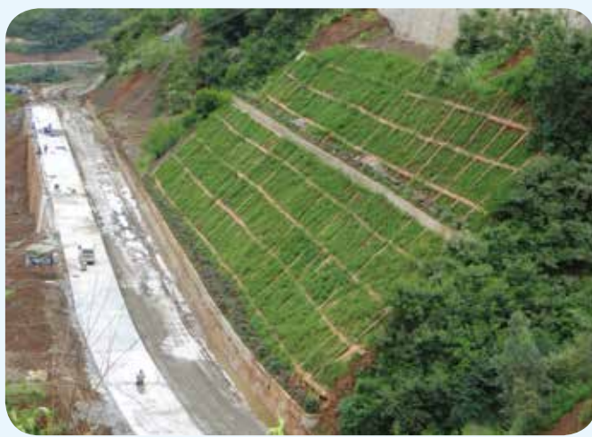
白鹤滩工程1号公路上村梁子段边坡支护
