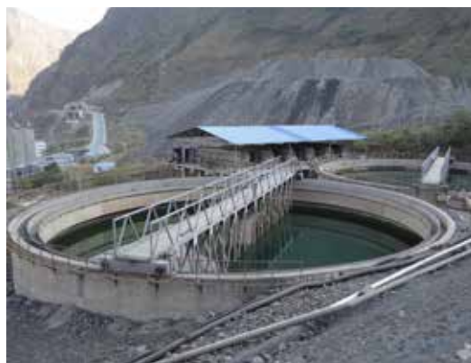
白鹤滩工程荒田砂石骨料加工废水处理系统
