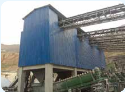
乌东德工程下白滩生产车间密闭
