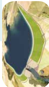
加纳合芒水电站 (EPC 项目, 装机容量 93MW)
