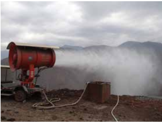
白鹤滩工程施工降尘
