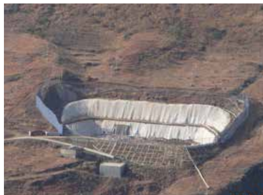
白鹤滩工程生活垃圾填埋场
