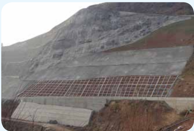
乌东德工程延吉沟边坡治理工程
