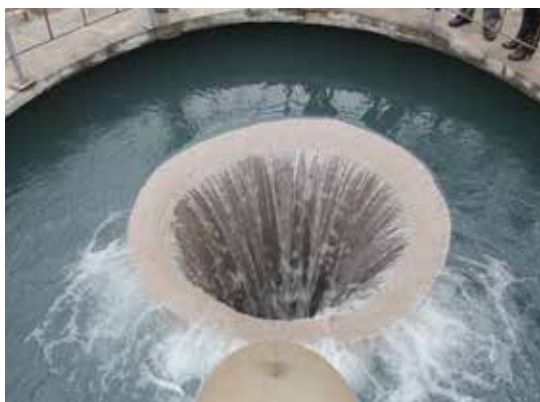
向家坝工程混凝土生产废水处理系统
