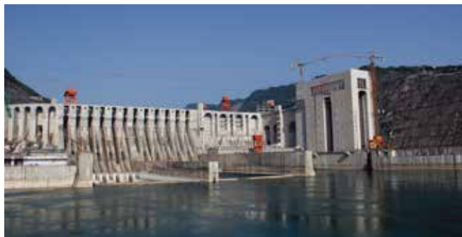
向家坝工程泄洪消能措施
