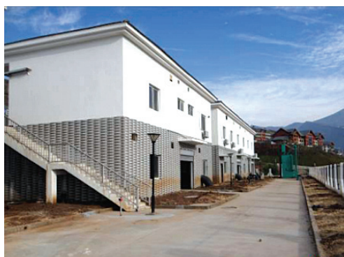
白鹤滩上村梁子污水处理
