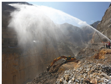
乌东德右岸坝肩边坡开挖洒水降尘
