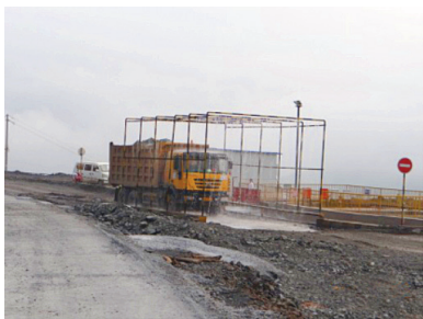
白鹤滩弃渣场冲淋装置
