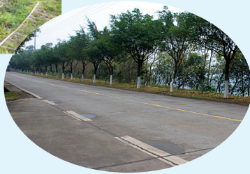
施工区道路绿化
