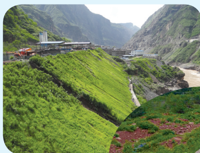
下游永久桥右岸边坡绿化
