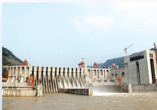
向家坝工程跌坎式底流消能泄洪措施
