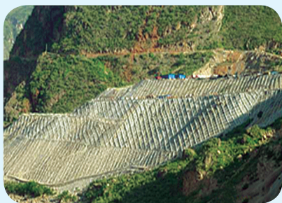
右岸施工场地沿江边坡格网防护
