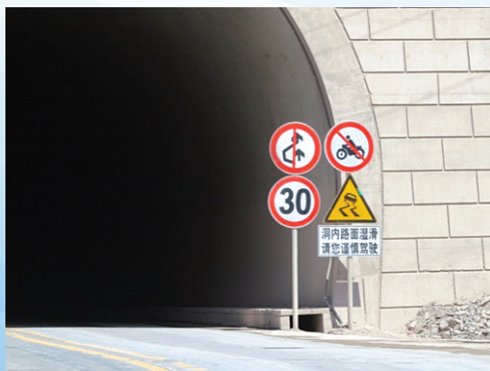
乌东德工程施工场内限速牌
