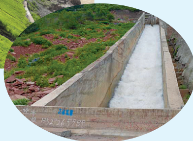
矮子沟弃渣厂防护
