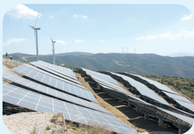
光伏设备安装
