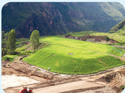
右岸表土堆存场植被防护
