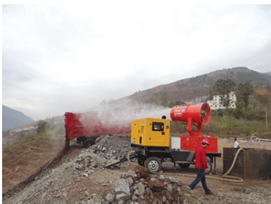
白鹤滩弃渣作业喷雾降尘
