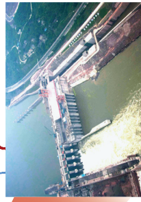
葛洲坝水利枢纽
