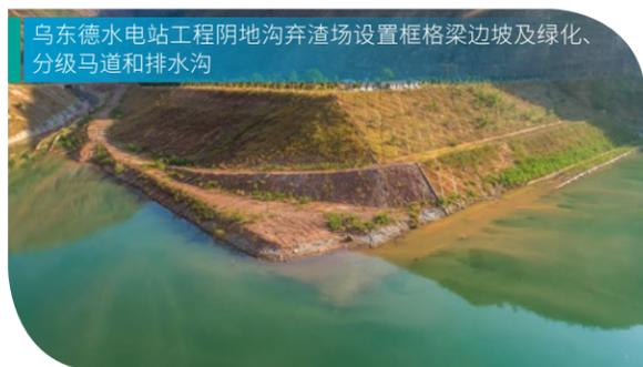
乌东德水电站工程阴地沟弃渣场设置框格梁边坡及绿化、分级马道和排水沟
