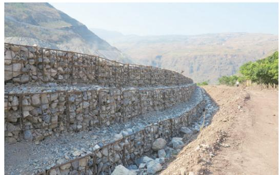
图：乌东德鲢鱼河渣场坡脚挡护
