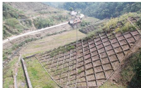
图：向家坝骨料输送线弃渣场网格护坡
