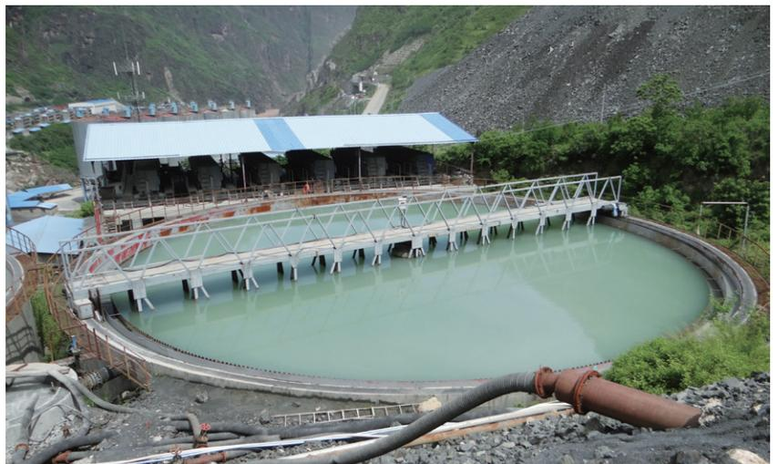
图：白鹤滩荒田砂石加工废水处理系统
