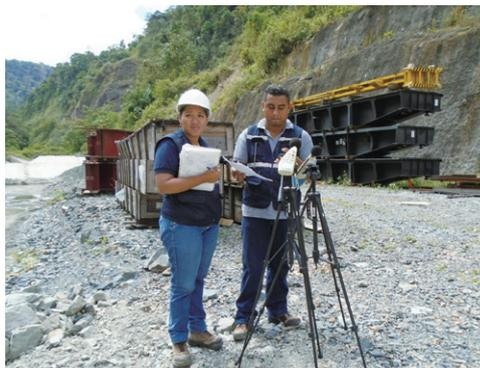
图：厄瓜多尔TP水电站项目施工厂界噪声监测
