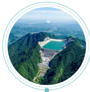
长龙山抽水蓄能电站
