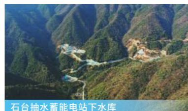
石台抽水蓄能电站下水库
