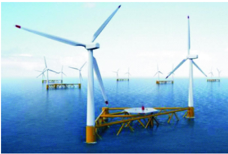
图 6 Hexicon 的双风机半潜式基础图
