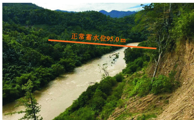
图2 坝址现状图(上游视)
