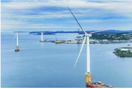
图 5 Hywind spar 单柱式基础图
