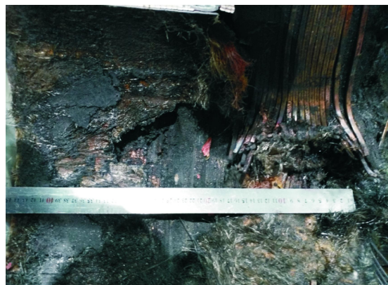
图6 高压线圈首段解体情况图
