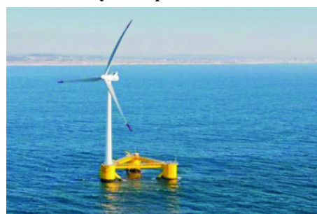
图 3 WindFloat 漂浮式基础图
