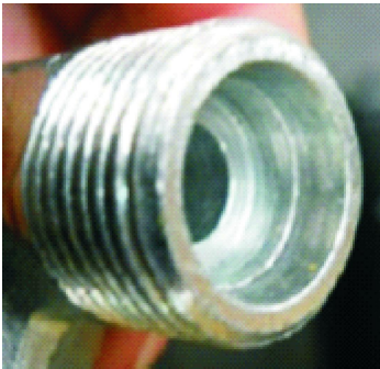
图 5 接头体内锥面损坏实物图
