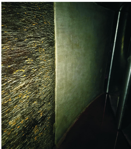
图10 4号机空心固定导叶表面涂抹抗磨层后图
