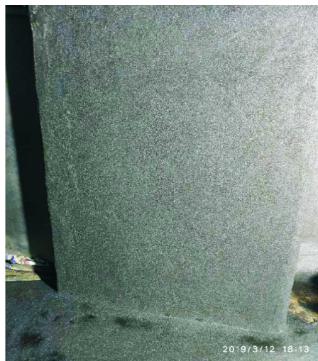
图13 1号机座环固定导叶表面涂抹抗磨层后图
