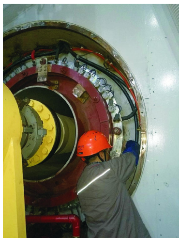
图6 集电环负极处只能站一人图
