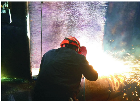
图4 座环固定导叶补焊图
