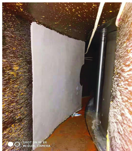
图11 4号机抗磨层运行8年后图
