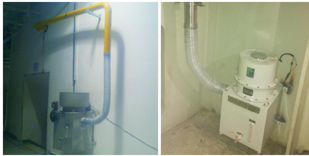
图5 壁挂式吸油雾装置图
